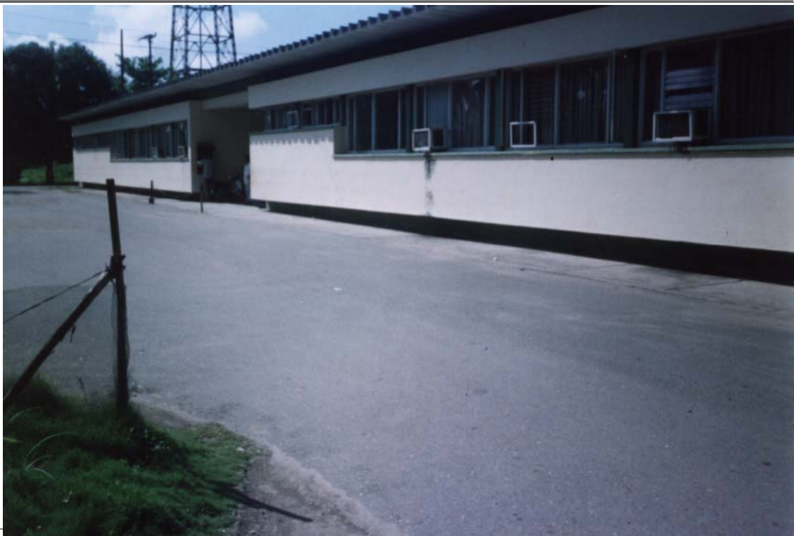
Fotografía 6. Fachada de Acceso al Hospital José Cayetano Vásquez.
