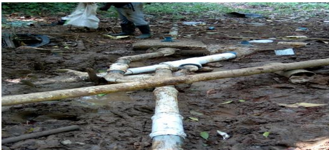
Punto de Unión Tubería Conducción de las bocatomas del Barrero y Punta Brava.
