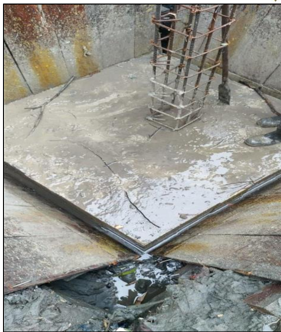
Foto 8: Zapata en concreto de 3000 psi
