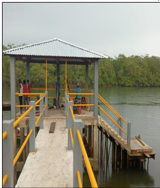
Foto 15: Armado de Escalera para su fundida Foto 16: escalera de muelle fundida
