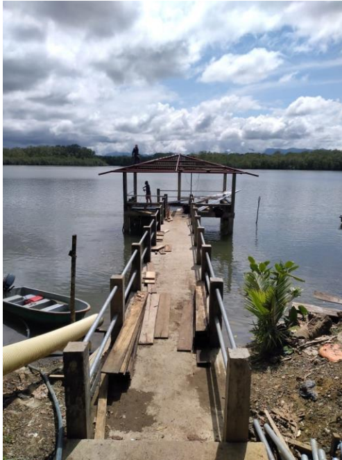
Foto 1: Placa de muelle fundida
