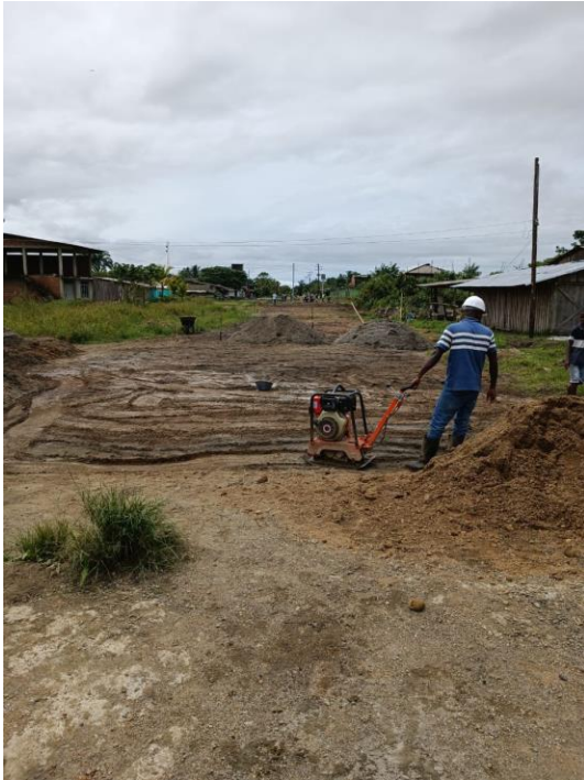
Foto 1: avance en Adecuación de Suelo. drenaje
