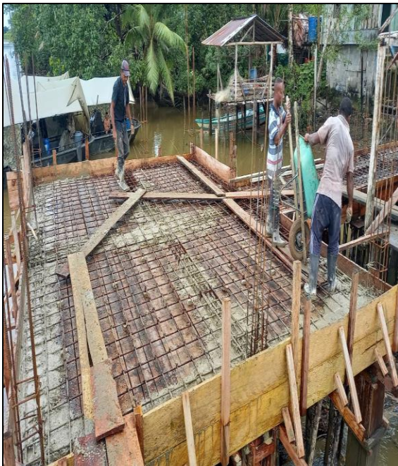
Foto 13: Fundida de concreto para placa
