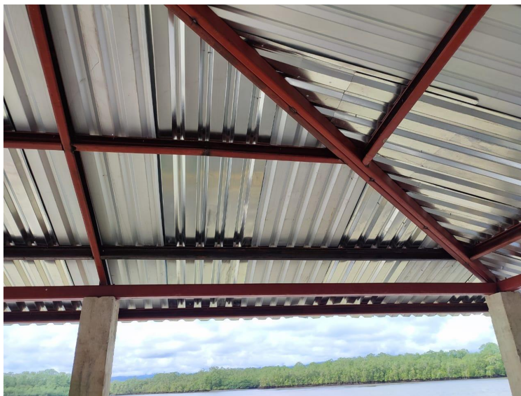
Foto 5: Estructura de cubierta de muelle
