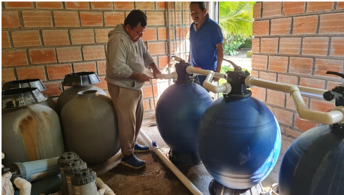
Foto 1: Remplazo e instalación de nuevos filtros
