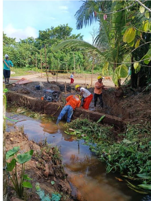
Foto 2: Avance en estructura de
