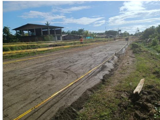
Foto 5: avance de obra
