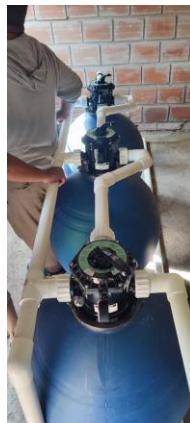
Foto 4: Suministros e instalaciones de filtros
