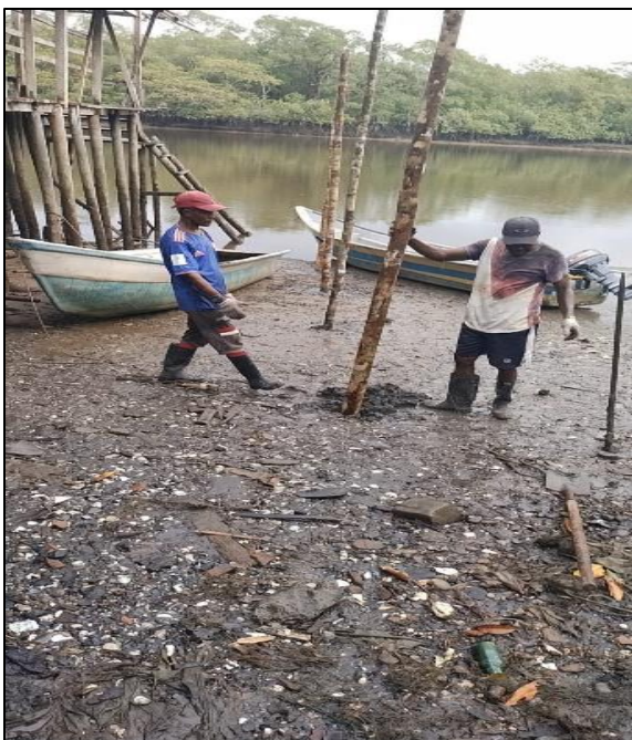
Foto 3: Localización y replanteo
