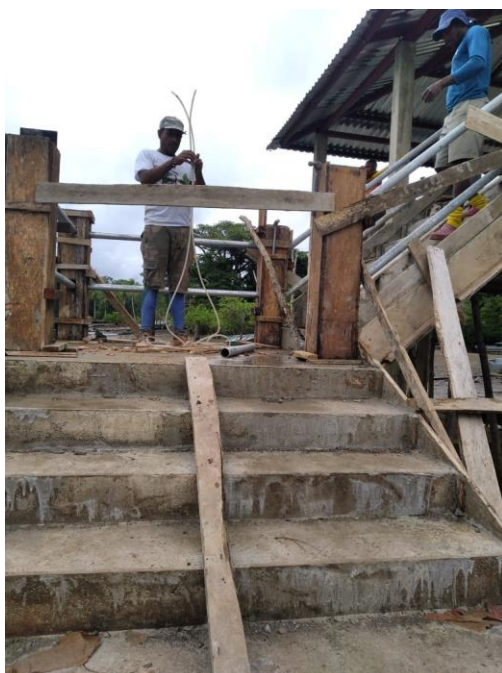
Foto 4: Armado de Escalera para su fundida
