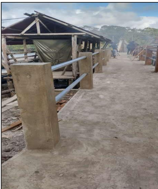
Foto 19: Instalación de pasamanos de muelle Foto 20: Pasamanos de muelle terminados
