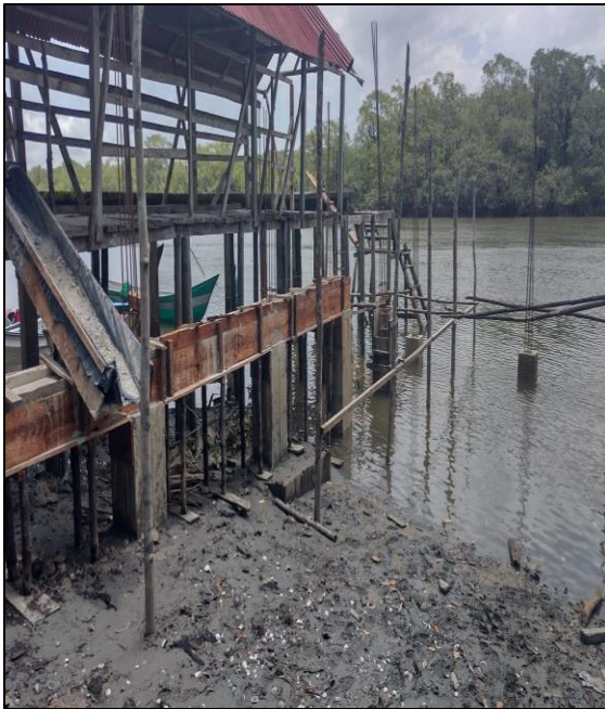
Foto 11: Pedestales y Viga de cimentación
