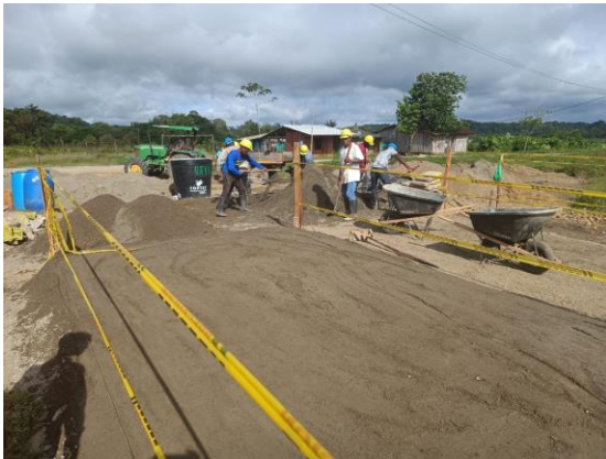
Foto 4: avance de obra
