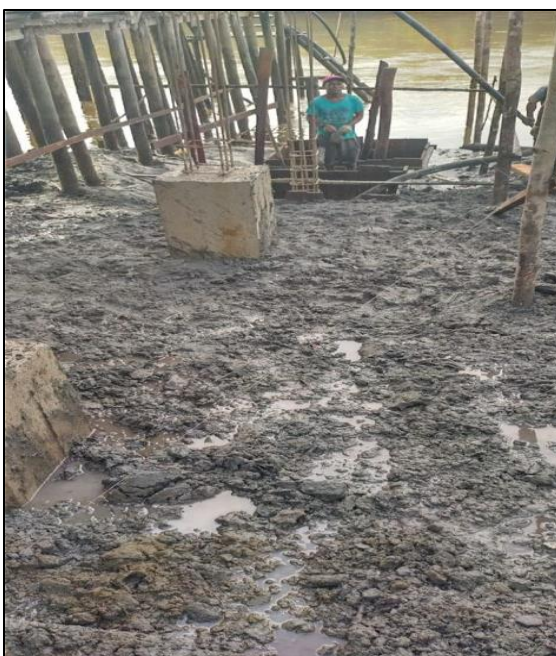
Foto 9: Pedestales en concreto y llenos de zapatas
