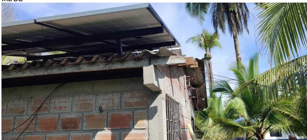
Foto 5: Instalación de paneles solares
