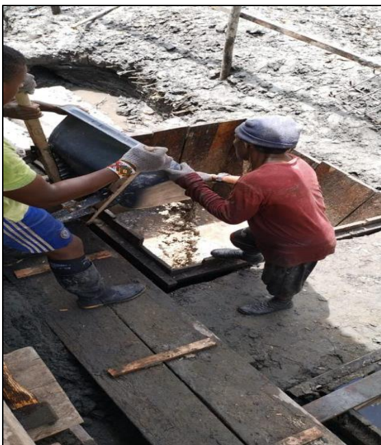
Foto 7: Aplicación de Solado de limpieza
