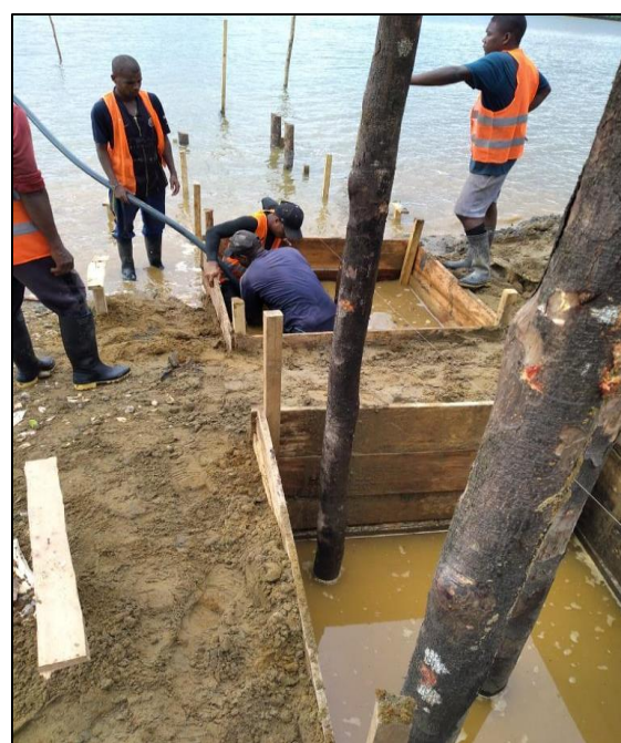
Foto 6: Obreros hincando pilotes
