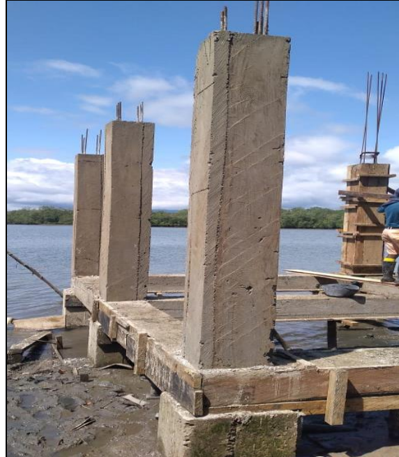
Foto 12: Columnas fundidas
