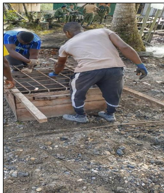
Foto 10: Acero de refuerzo de 60000 psi
