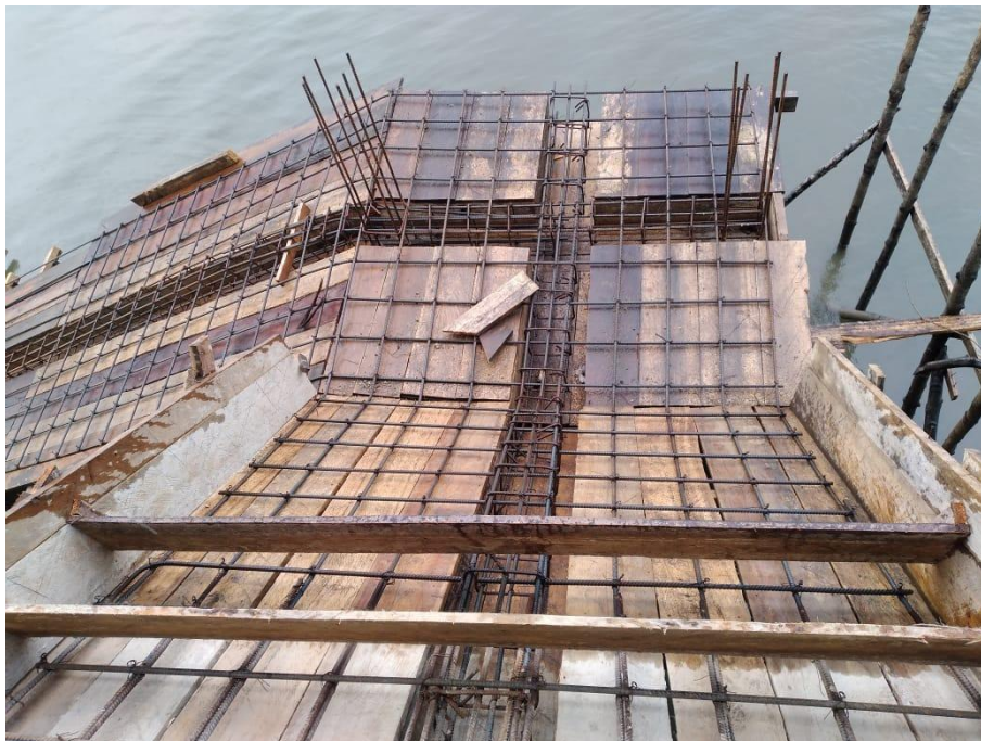
Foto 4: Armado de Escalera para su fundida
