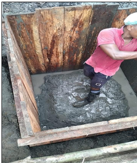
Foto 4: Excavación en material común
