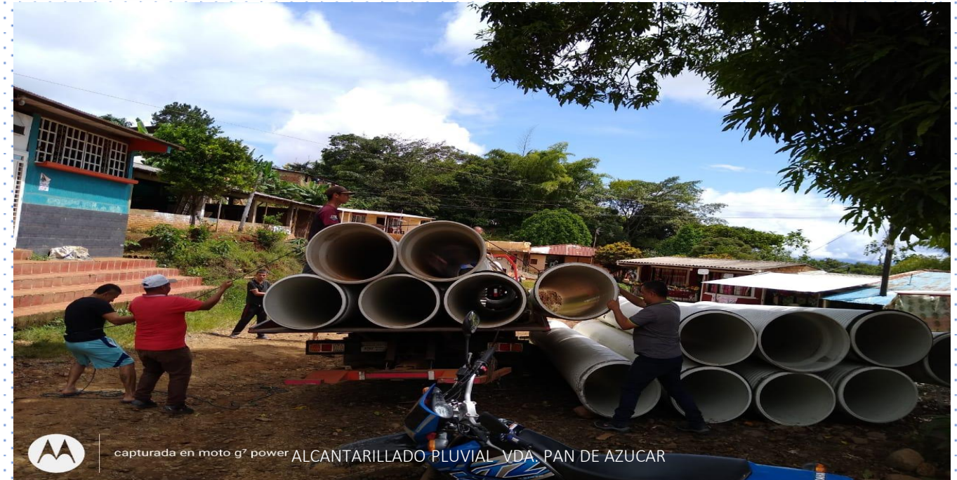
ALCANTARILLADO PLUVIAL VDA. PAN DE AZUCAR
