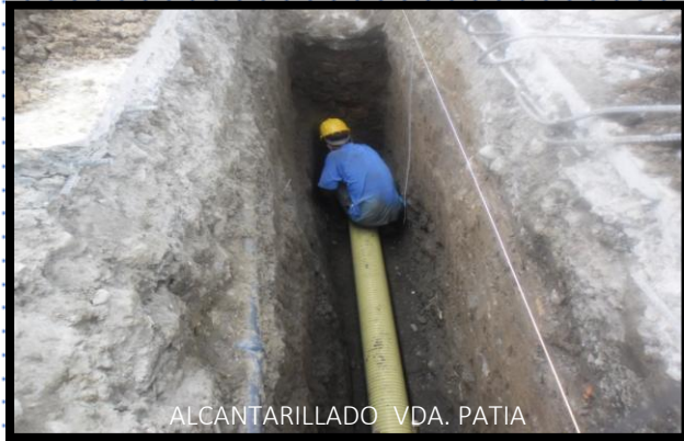
ALCANTARILLADO VDA. PATIA
