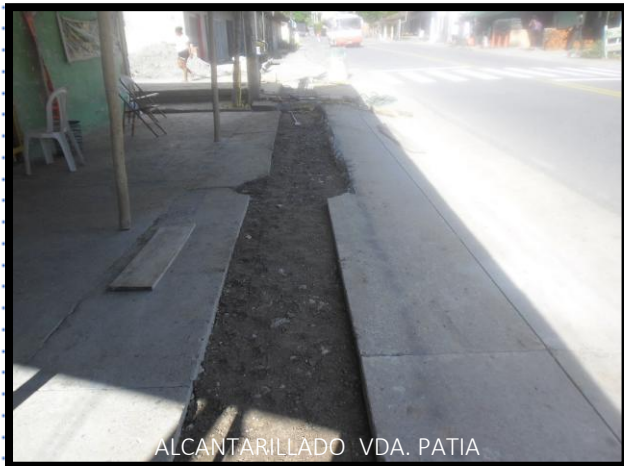
ALCANTARILLADO VDA. PATIA
