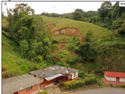
Deslizamiento rotacional, sector Alegrías
