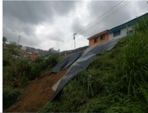
Sector la bomba, salida a Salamina, deslizamiento superficial y socavacion.
