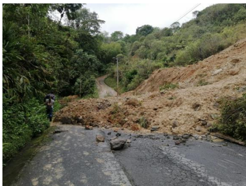
Deslizamiento traslacional, Variante, acceso barrio La Milagrosa
