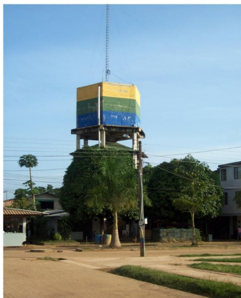
Tanque almacenamiento Centro
