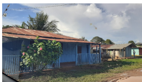
Localización: Barrio La Victoria
