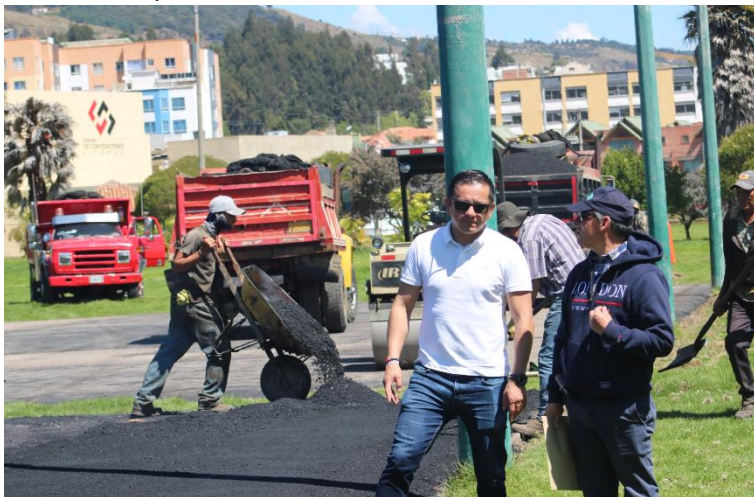
Imagen 15 Mejoramiento de la capa asfáltica
