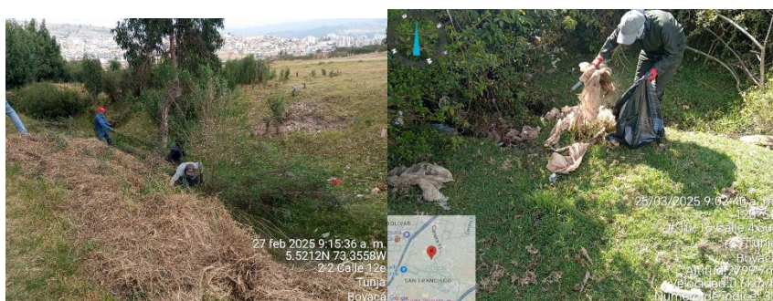
Imagen 34 Limpieza Cárcavas San Antonio, Libertador, Mirador Escandinavo y Ricaurte
