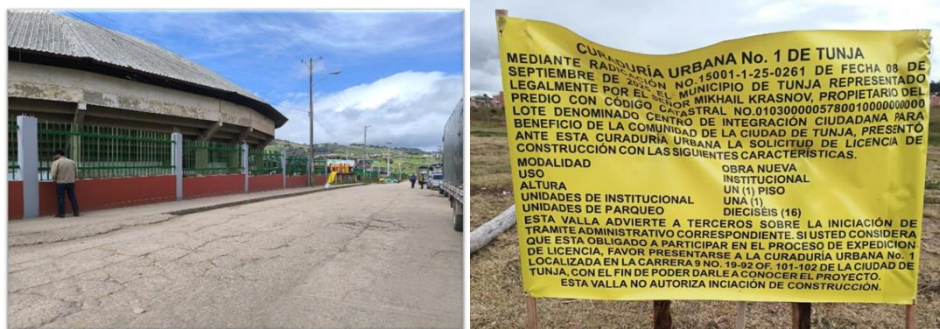
Imagen 73 Fachada plaza de mercado Sur
