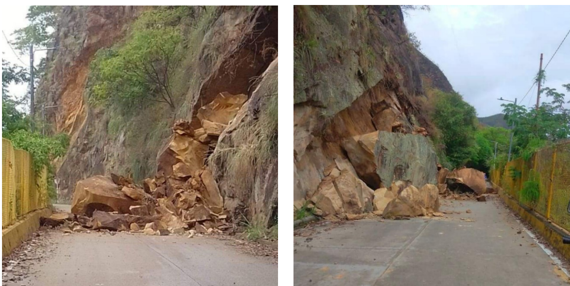
Imagen. Deslizamiento 22 de septiembre de 2022 vía al puerto
