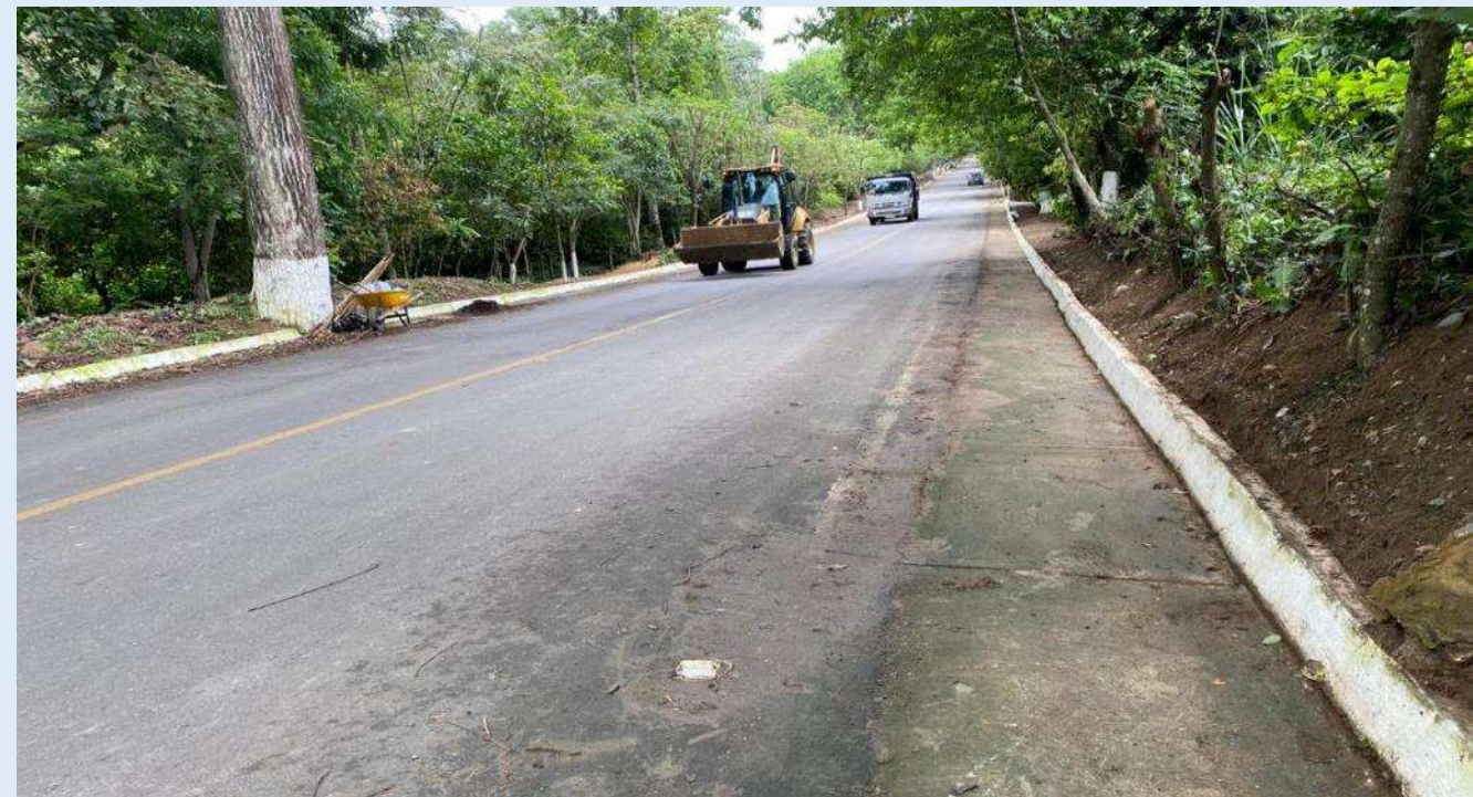
Limpieza y ornato en la Entrada del Municipio Baraya
