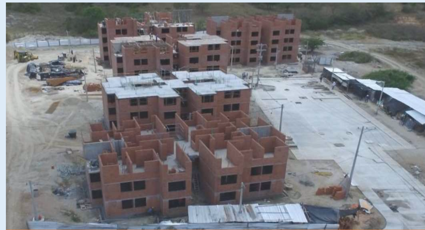
100 viviendas en construcción de la urbanización Villas del Carmen
