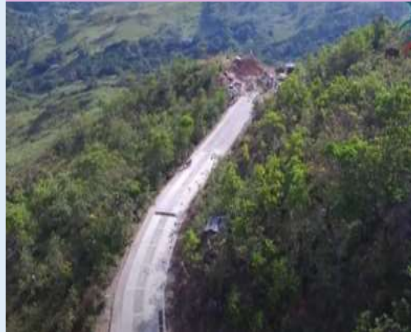
Entrega de 4 KM de Construcción placa Huella via la Troja
