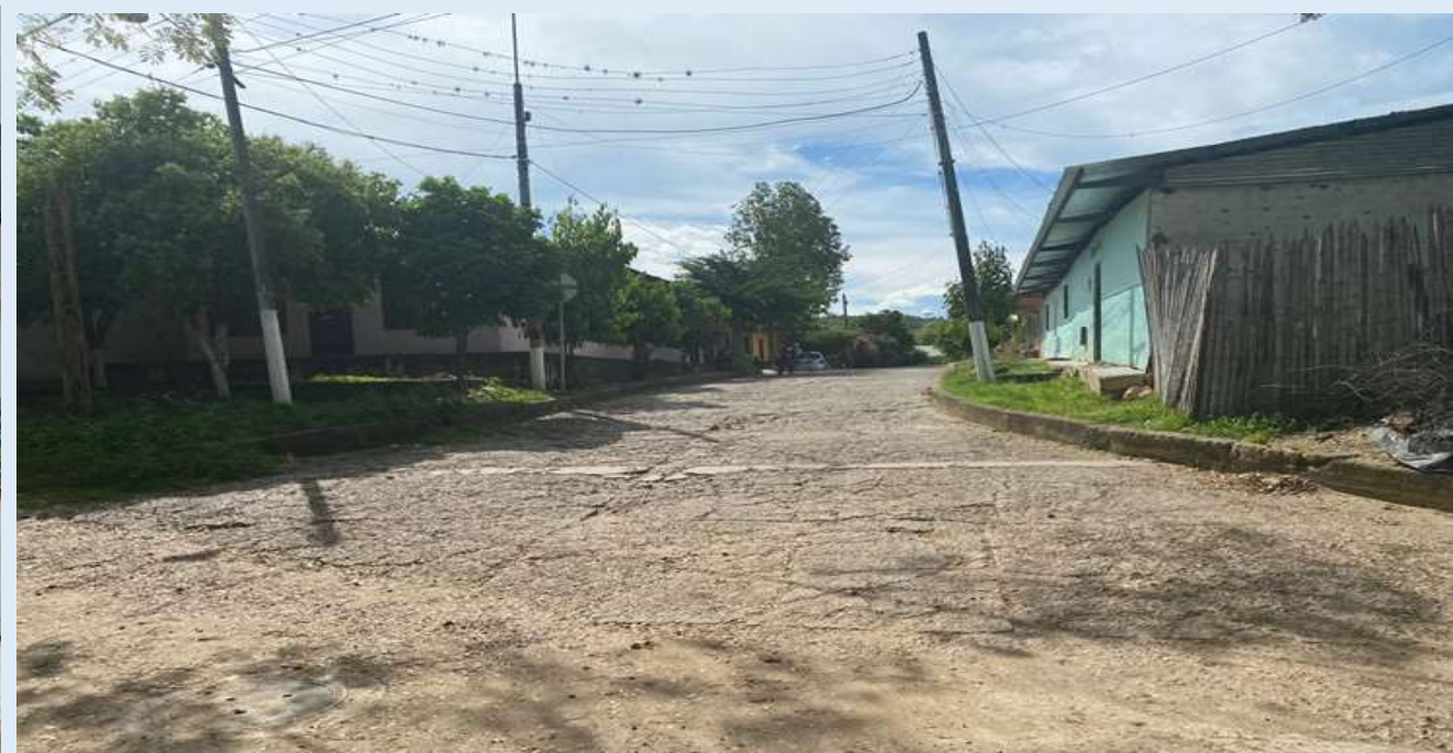
Reposición del alcantarillado de las carrera10 entre calle 1B y 1C, del Barrio Gaitán de Baraya
