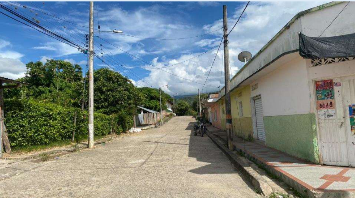
Reposición del alcantarillado de la Calle 4 entre Carreras 5 y 6, de los Barrios la Cruz y Centro
