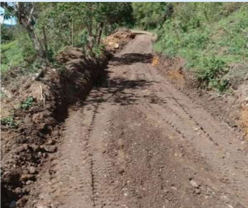
Rehabilitación de las vías de las veredas Totumito, Soto, Laureles, La libertad entre otros
