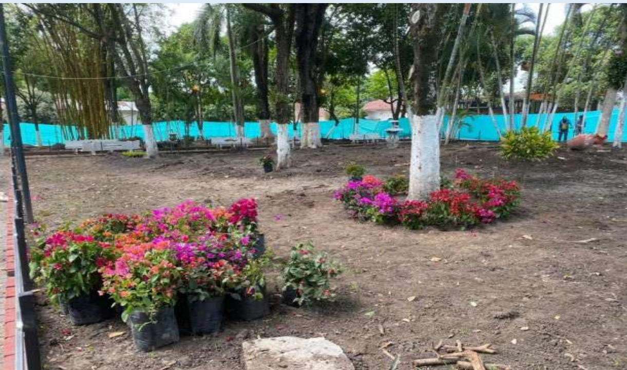
Intervención en el Parque central
