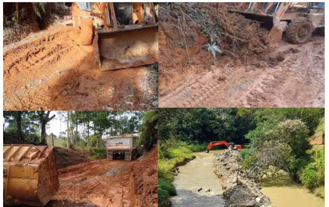
Se realiza remoción y cargue de derrumbes en el polo de desarrollo de La Alejandría, La Gallinera y El Cinco, Además se realizan intervenciones para mitigar el colapso del puente vehicular de la vereda San Juan. $19.985.901
