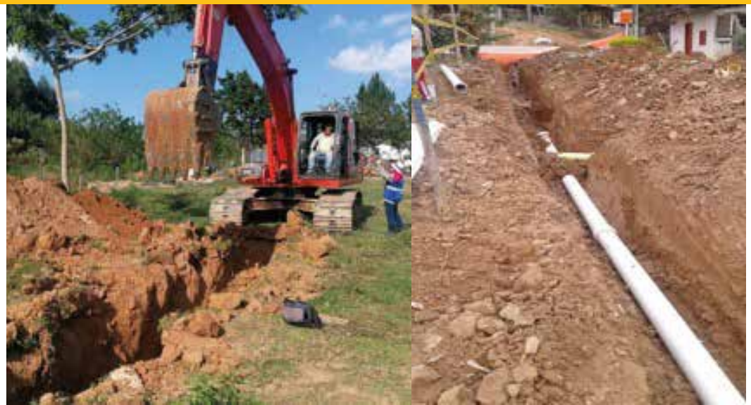
Reparación de MH hundido en la paz 1, instalación de 650 metros de tubería de acueducto en el barrio la planta, cambio de las bombas sumergibles de la EBAR (2020).
