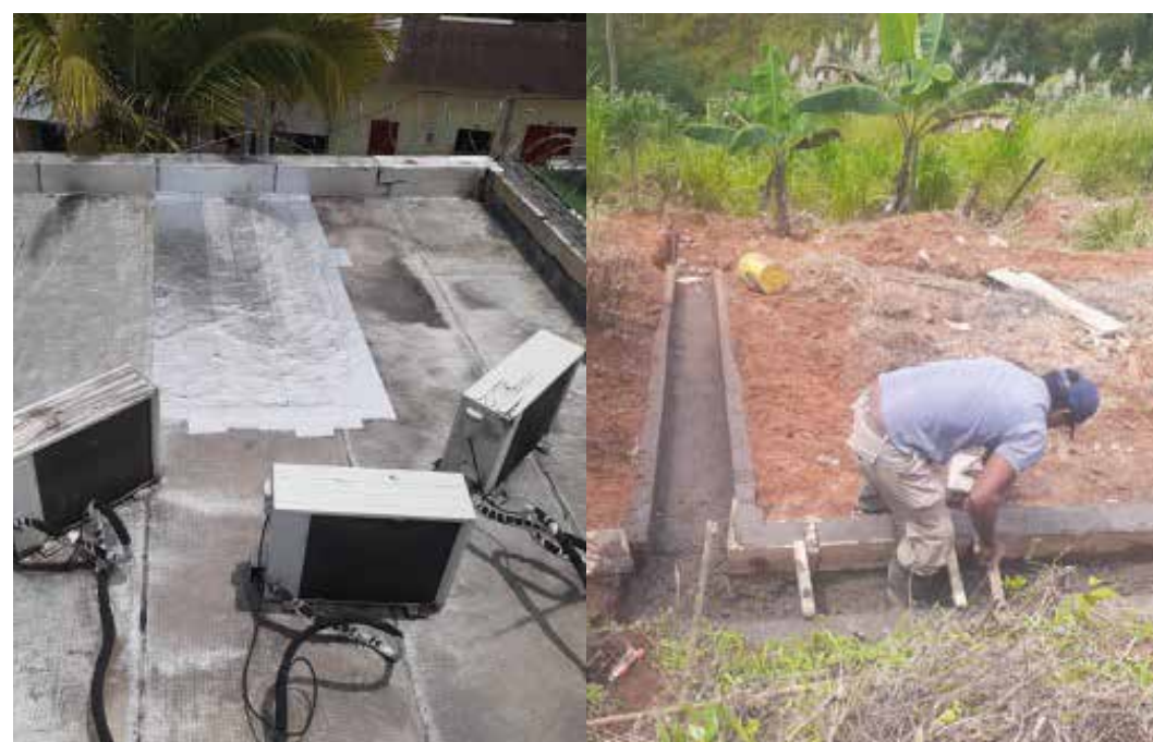
Adecuación y mantenimiento Subestación de Policía del Corregimiento El Tigre. $ 51.046.680. (En ejecución)
