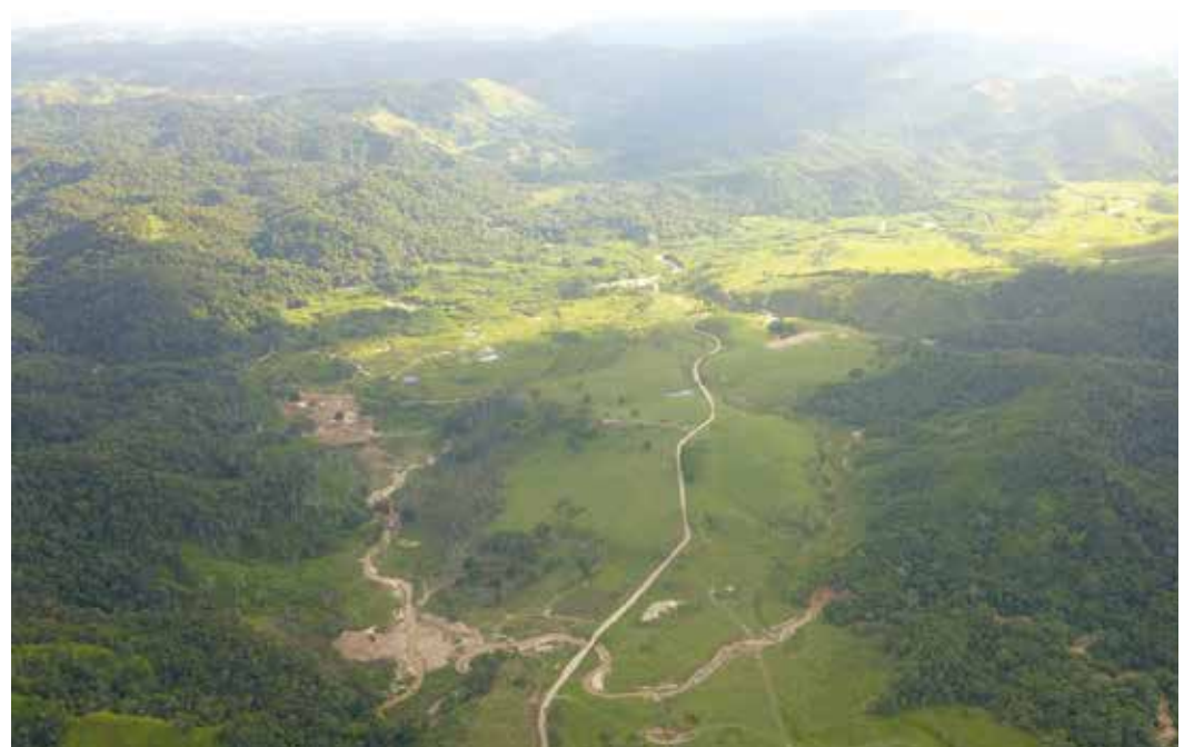
Pavimentación de 3,3 km en la vía que comunica a polo de desarrollo El Cinco $7'000.000.000
