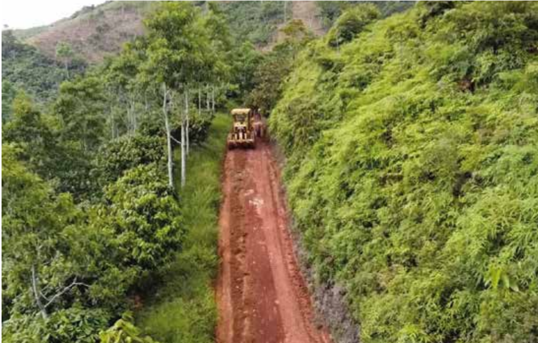
Mantenimiento de vías terciarias en las veredas: El Pescado, La Palma, Tigre-Mata Baja, El Lagarto y La Clarita $32.000.000
