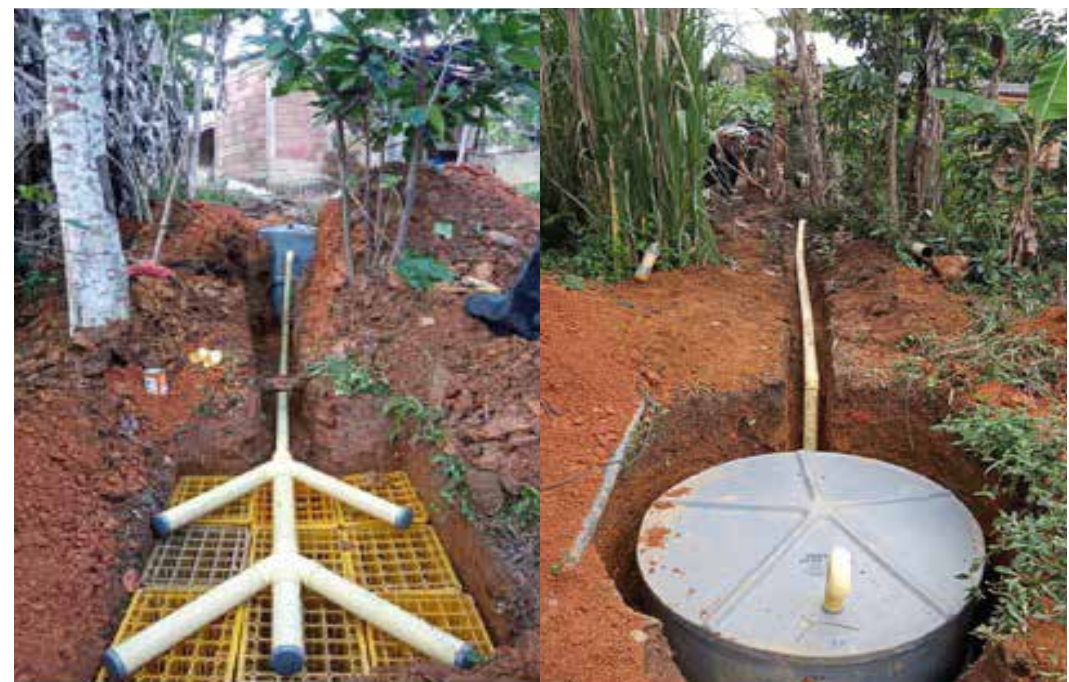
Instalación de 58 pozos sépticos veredas San Pascual, Bellavista, La Gallinera y Piedrancha (en convenio con Planeación)
