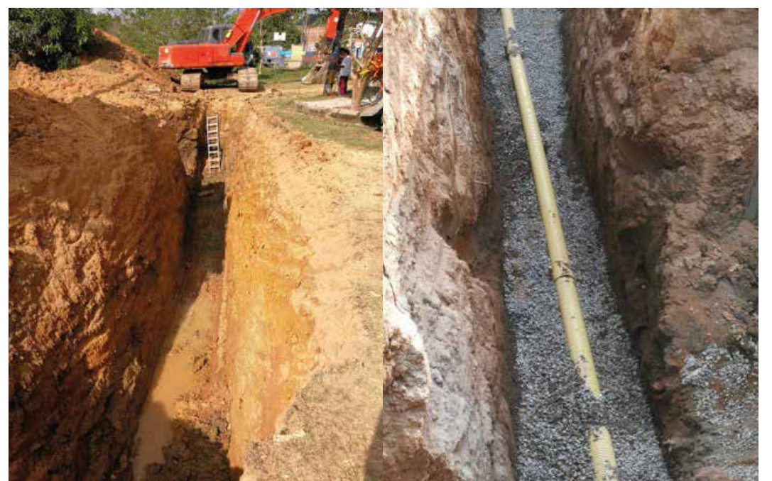
Mejoramiento de redes de acueducto y solución a la problemática de evacuación de aguas residuales población beneficiada 2.000 personas
