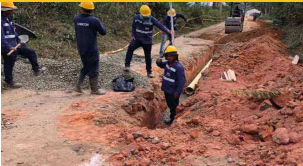
Construcción y optimización de 1600 metros de red de alcantarillado y 1500 metros de red de acueducto de la recta del comando, la Paz 1 (2020).
