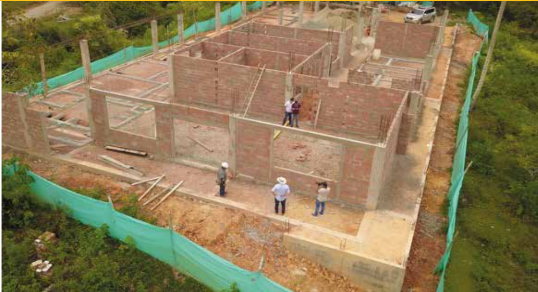
Construcción del Centro de Protección Social del Adulto Mayor – CPSAM (2021).
