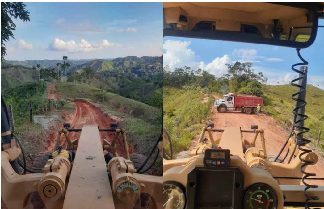
Mantenimiento de puntos críticos en la vía que conduce a las veredas la Unión y Corinto, se intervinieron cerca de 18 kilómetros de vías rurales. $177.755.274
