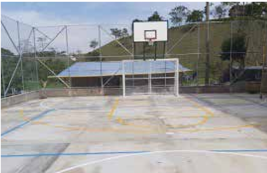
Obras de terminación de placa deportiva en la vereda El Cinco.
