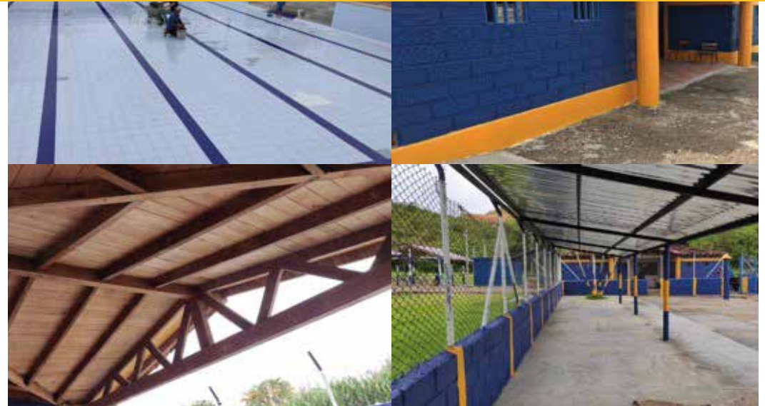
Adecuación y mantenimiento de la piscina Municipal (2020).
