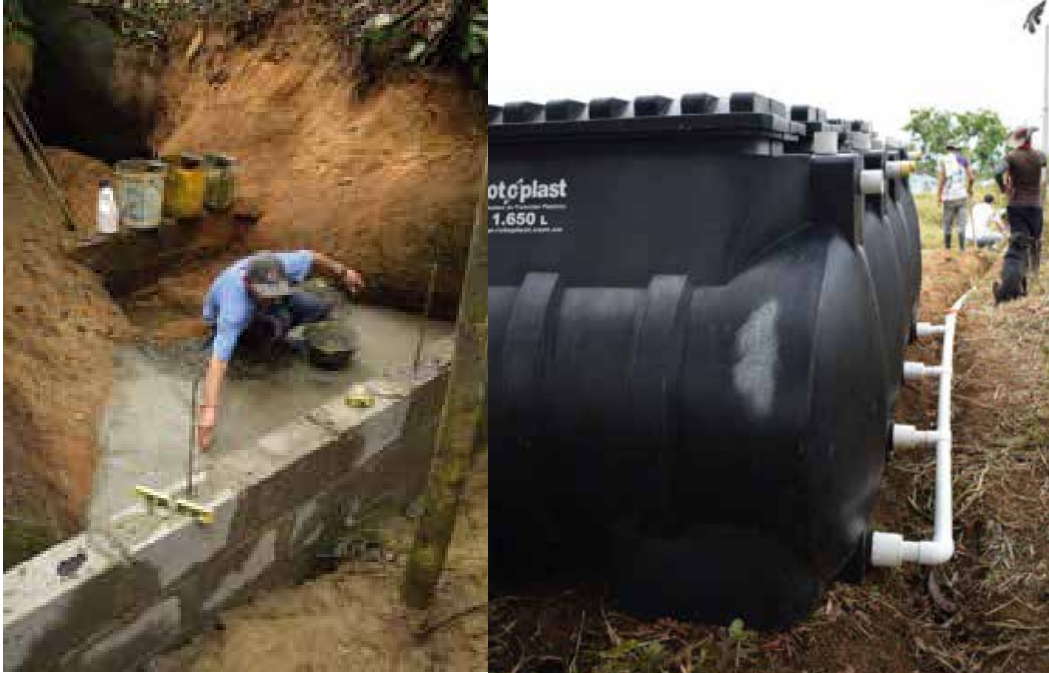
Construcción de la captación, conducción y los tanques de almacenamiento del acueducto del sector de Sierra Baja (2020).
