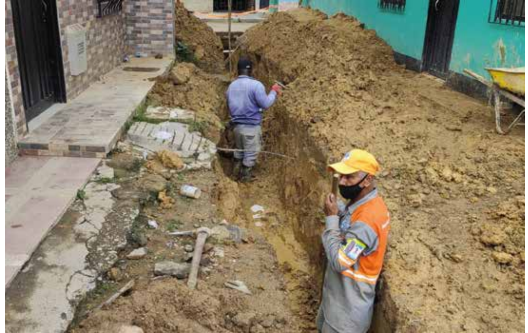
Reposición e instalación de redes de acueducto y alcantarillado del Callejón la Tutela.
