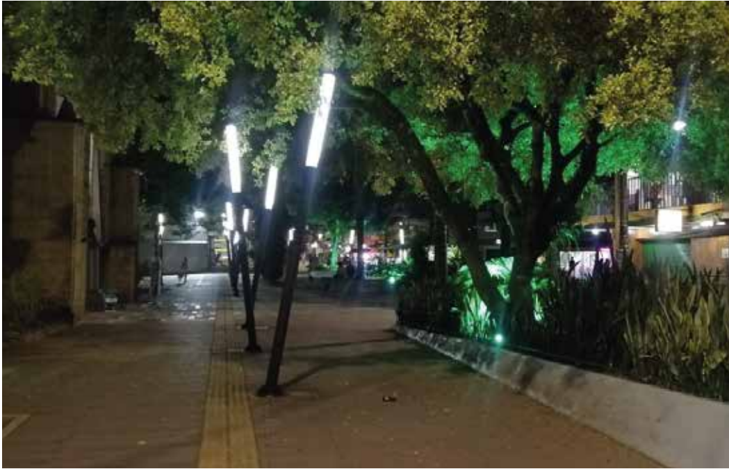
Mejoramiento y adecuación, del sistema de alumbrado del parque principal
