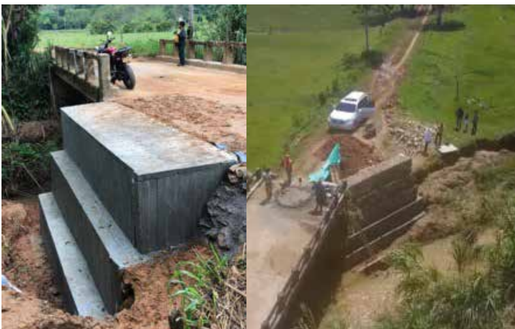
Construcción y reparación de gaviones en lugares en el sector de Cristo Rey, se repararon los gaviones perimetrales de la quebrada la Gallinera y se construyeron gaviones en las veredas El Jabón y La Cristalina. $33.791.033
