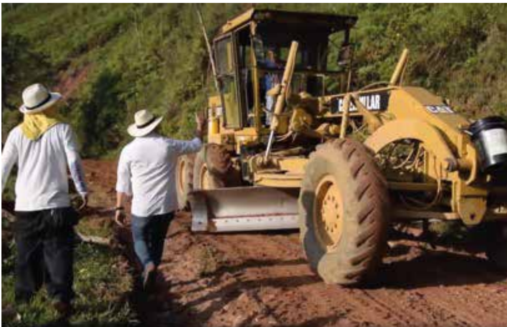
Mantenimiento de vías terciarias en los polos de desarrollo La Alejandría, La Gallinera, El Cinco y El Tigre. (2021)
