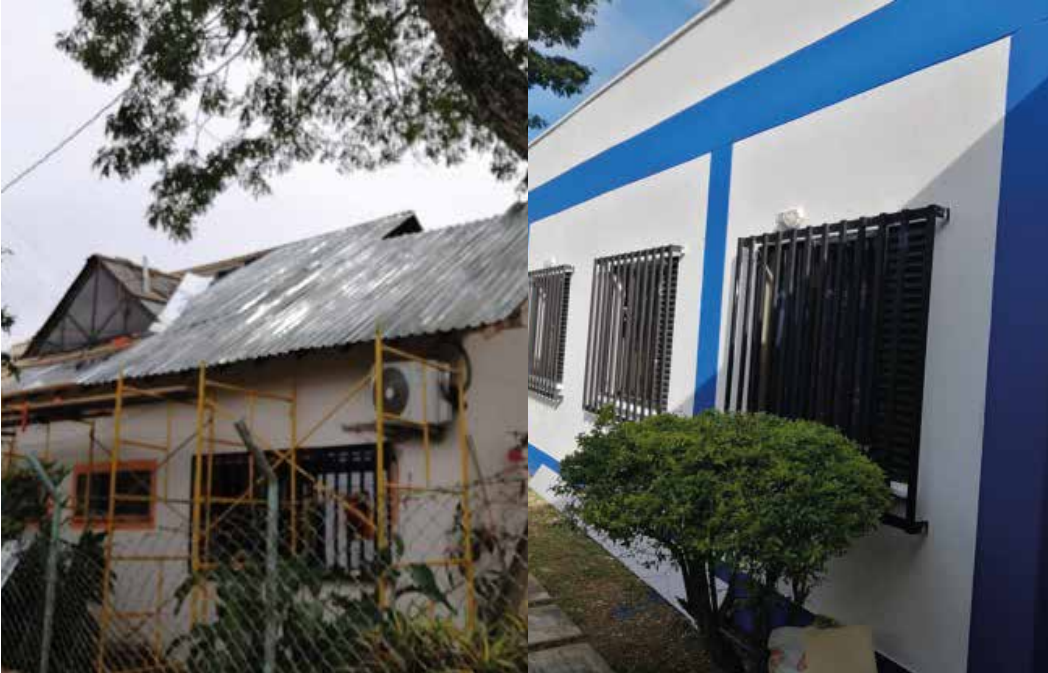
Implementación de la estrategia: EL PODER DEL SERVICIO PÚBLICO: ¿EN QUÉ LE PODEMOS SERVIR? Mantenimiento, adecuación y mejoramiento de espacios internos en la Casa de Justicia. $ 74.402.336.
