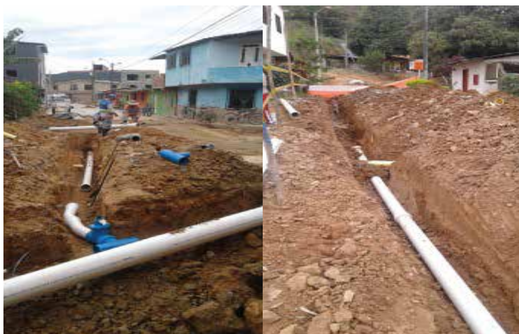
Instalación nuevas redes de acuerdo sector la planta, redes de alcantarillado e instalación nuevas bombas sumergibles
