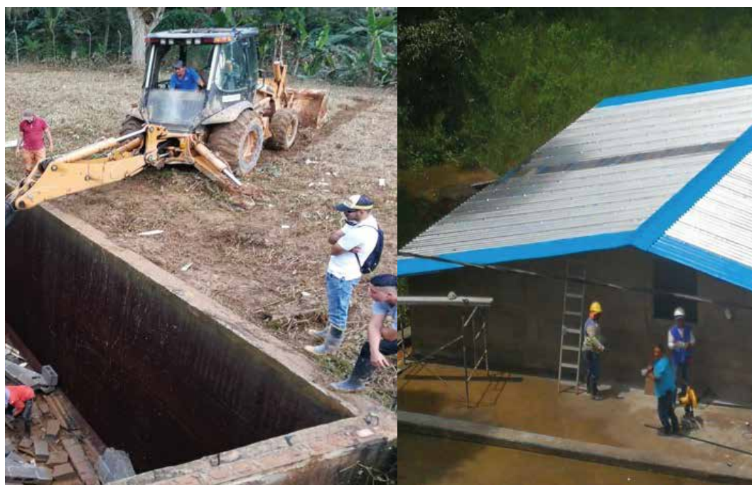
Construcción realce tanque de almacenamiento de agua potable. $35.000.000
