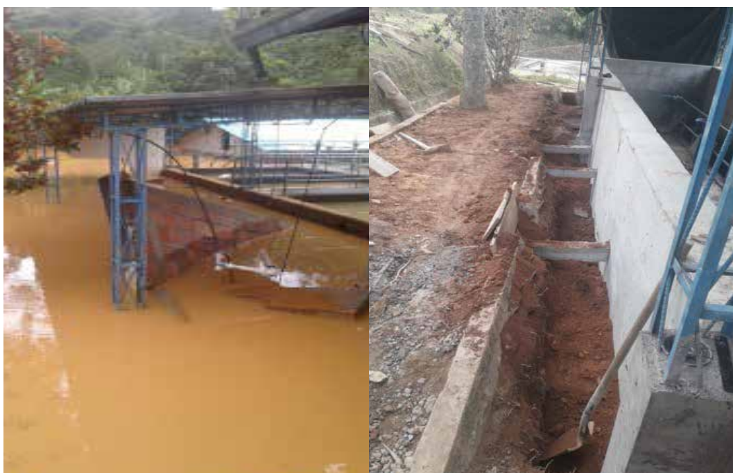
Construcción de nuevo muro en concreto reforzado. 📍 Planta de tratamiento $ 22.960.890
