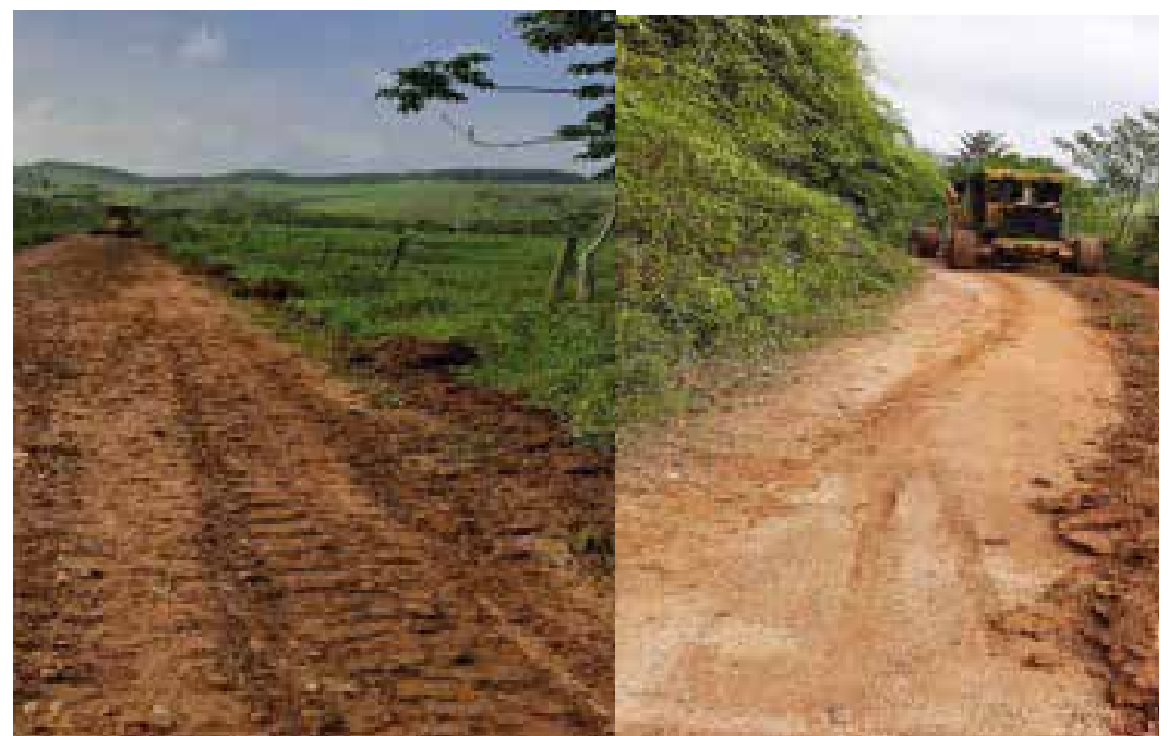
Mantenimiento de vía vereda Sierra baja, El Pescado, El Tigre, El Churú, Mata Baja, Mata alta y La Alejandría.
