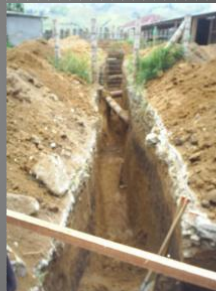
Excavación en zanja.
