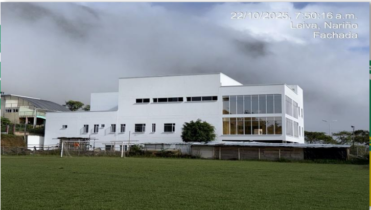
Construcción nuevo centro de salud San José del municipio de Leiva
