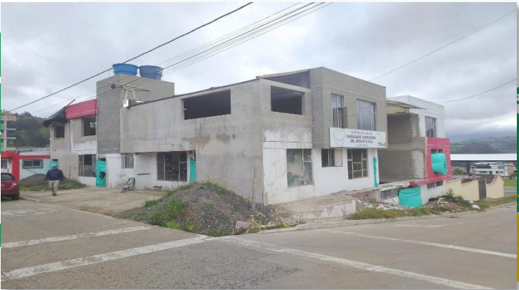
Remodelación Área De Consulta Externa Y Laboratorio Del Centro De Salud Sagrado Corazón De Jesús E.S.E. Contadero
