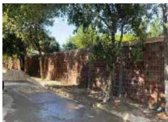
Muro perimetral Asilo San Martín de Porres
