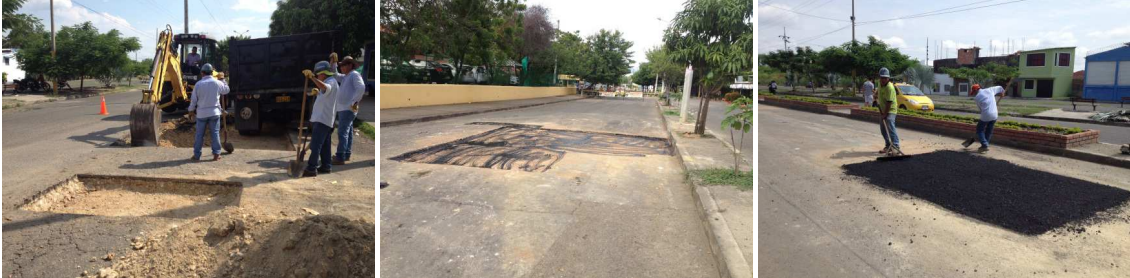
REPARCHEO BARRIO SAN MIGUEL
