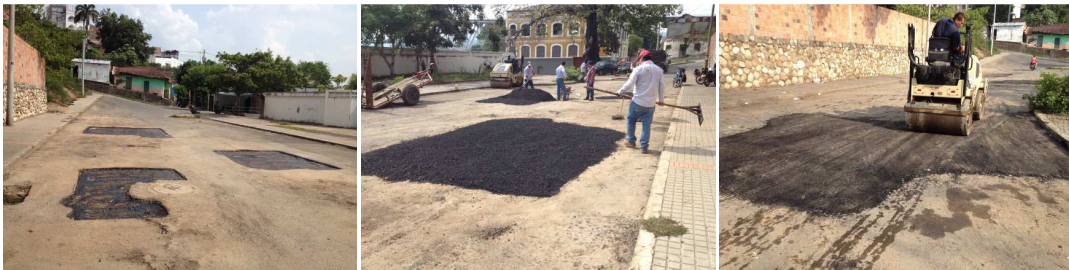
REPARCHEO BARRIO SUCRE SECTOR AV. FERROCARRIL
