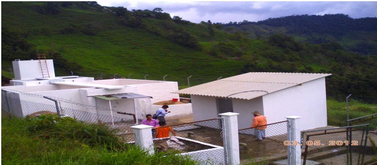
Planta de tratamiento agua potable área urbana. Registro fotográfico aportado por el coordinador PLEC's.
