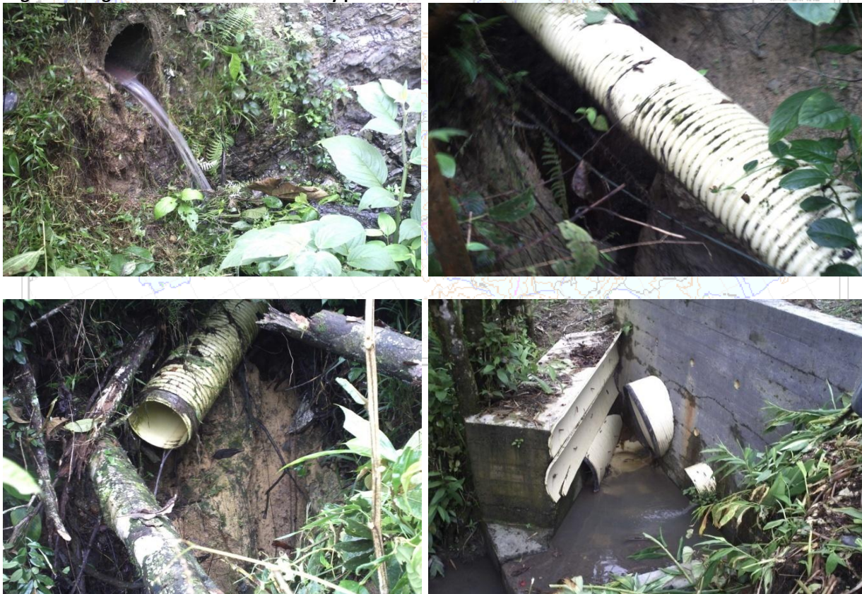
Registro fotográfico: red de alcantarillado y puntos de vertido.
