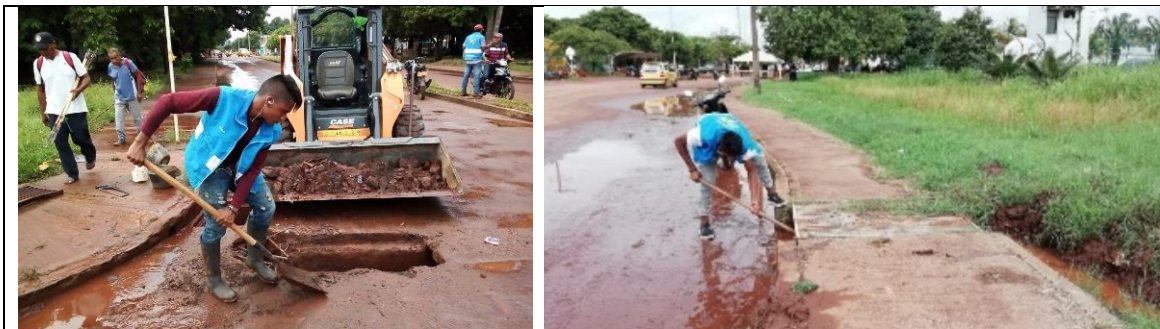
SE REALIZO LIMPIEZA A LAS TUBERÍAS DE DRENAJE DE AGUAS LLUVIAS, LAS CUALES ESTÁN UBICADAS EN EL AEROPUERTO Y EN EL PUERTO RESPETIVAMENTE
