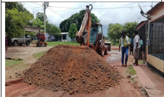
1.200 Metros Cúbicos de Relleno
