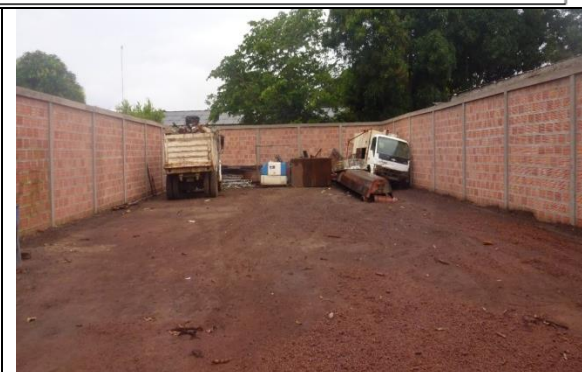
MURO DEMOLIDO PARA AMPLIACION
