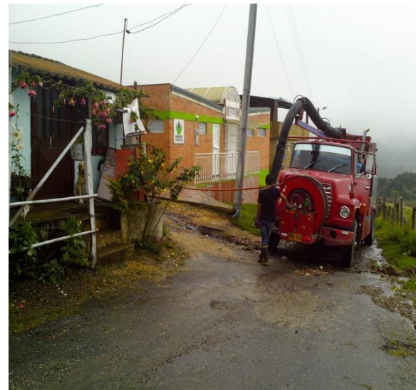
Vehiculó Bactor realizando la limpieza de cajas y sumideros vía Plaza de toros sector urbano
