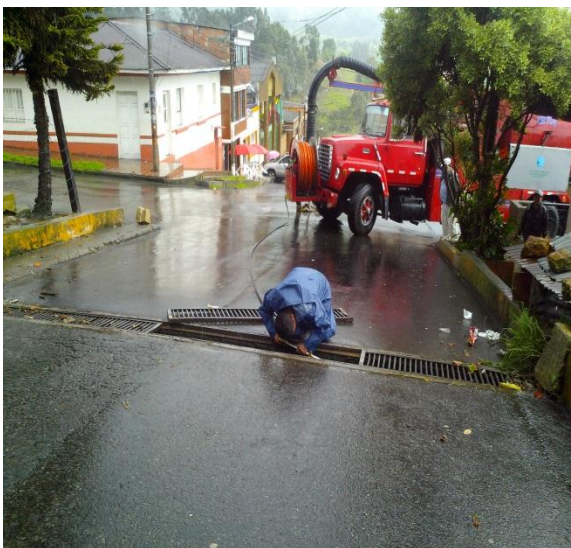
Vehiculó Bactor realizando la limpieza de cajas y sumideros vía Plaza de toros sector urbano
