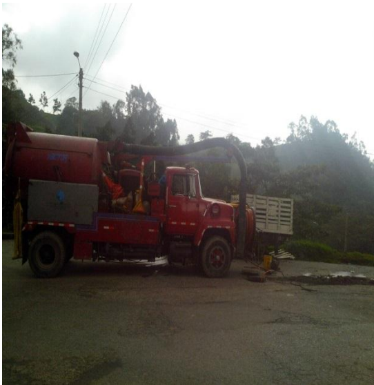
Vehiculó Bactor realizando la limpieza de cajas y sumideros vía Plaza de toros sector urbano
