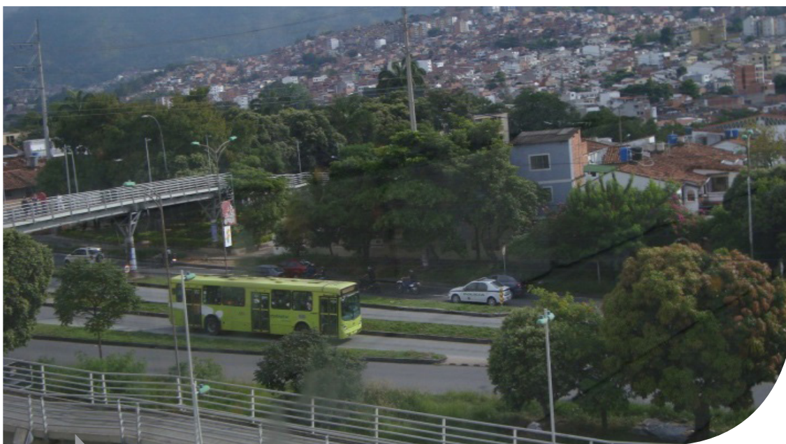
Sistema de Transporte Metrolínea – Autopista Floridablanca (CAEM-E3)
