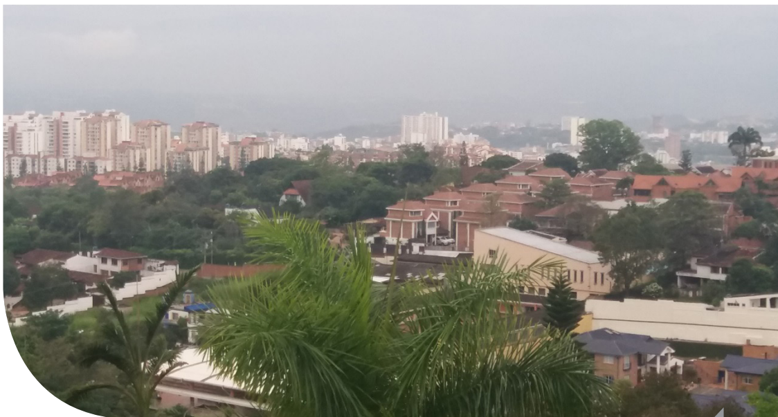
Vista Zona Lagos del Cacique –Bucaramanga –UT CAEM-E3
