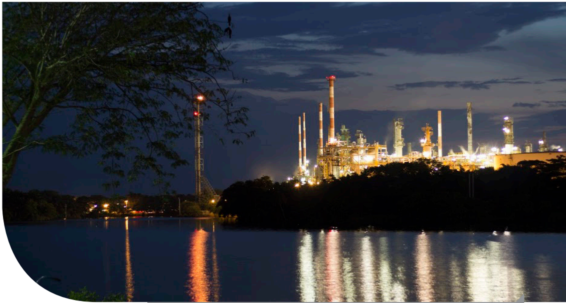
Vista externa Refinería de Barrancabermeja – Jaime Fernando Villamizar
