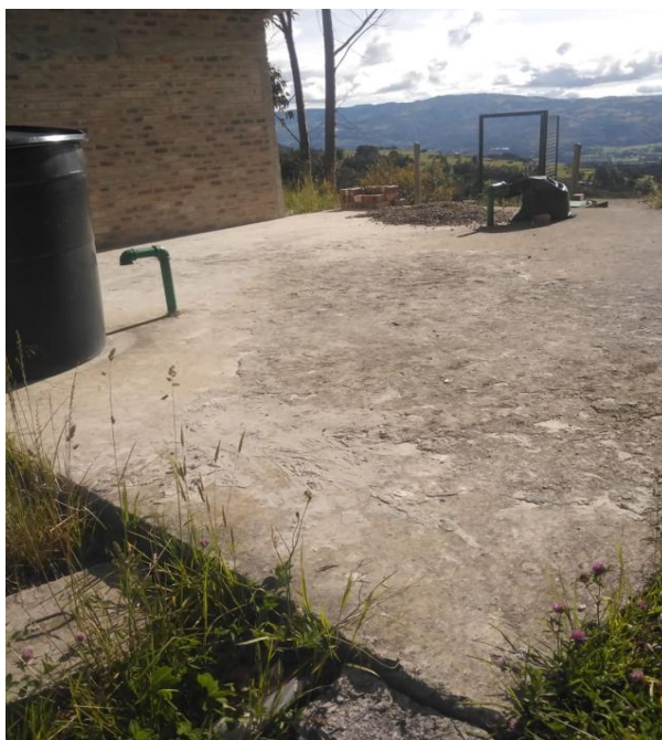
Figura 9. Estado físico de las instalaciones del acueducto comunitario
