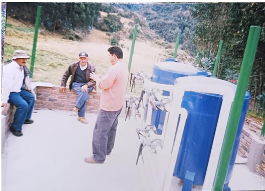
Figura 5. Instalación de tanques acueducto rural.
