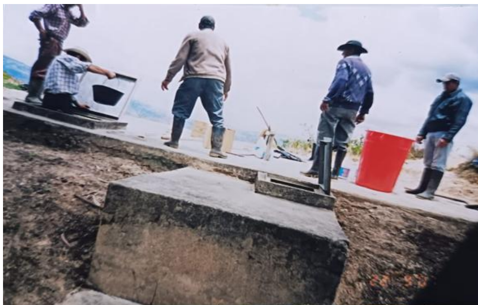
Figura 6. Limpieza de tanques acueducto rural.
