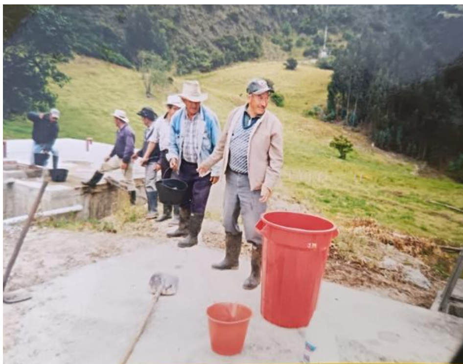
Figura 4. Fotografía histórica de la construcción del acueducto rural.
