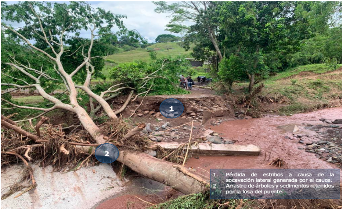
Imagen 13 Puente colapsado en el K0+850 vía “Supía – La Loma – Arcón”
