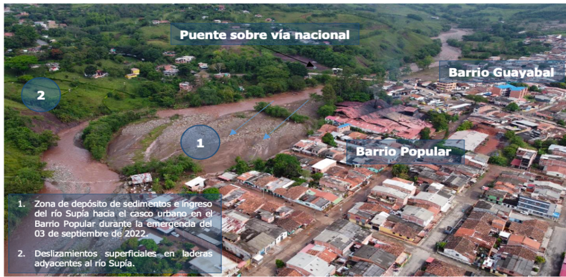
Imagen 5 Desbordamiento del río Supía en el sector del Barrio Popular
