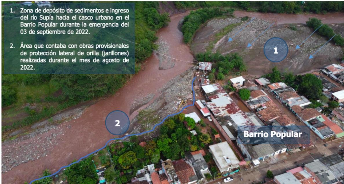
Imagen 6 Desbordamiento del río Supía en el sector del Barrio Popular
