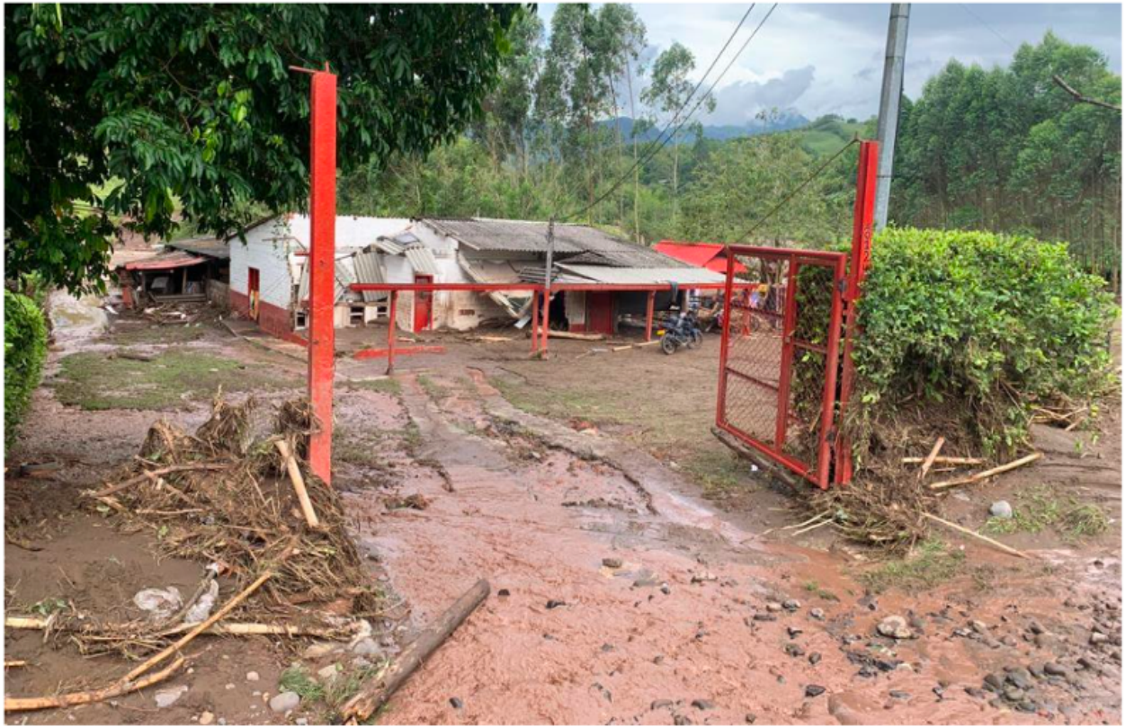
Imagen 10 Vivienda colapsada en el sector de la Central de Sacrificio a causa de flujo torrencial de la Quebrada Grande
