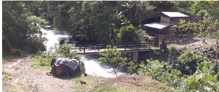
Concreto peatonal Pialapi a Pueblo viejo sobre río Pialapi
