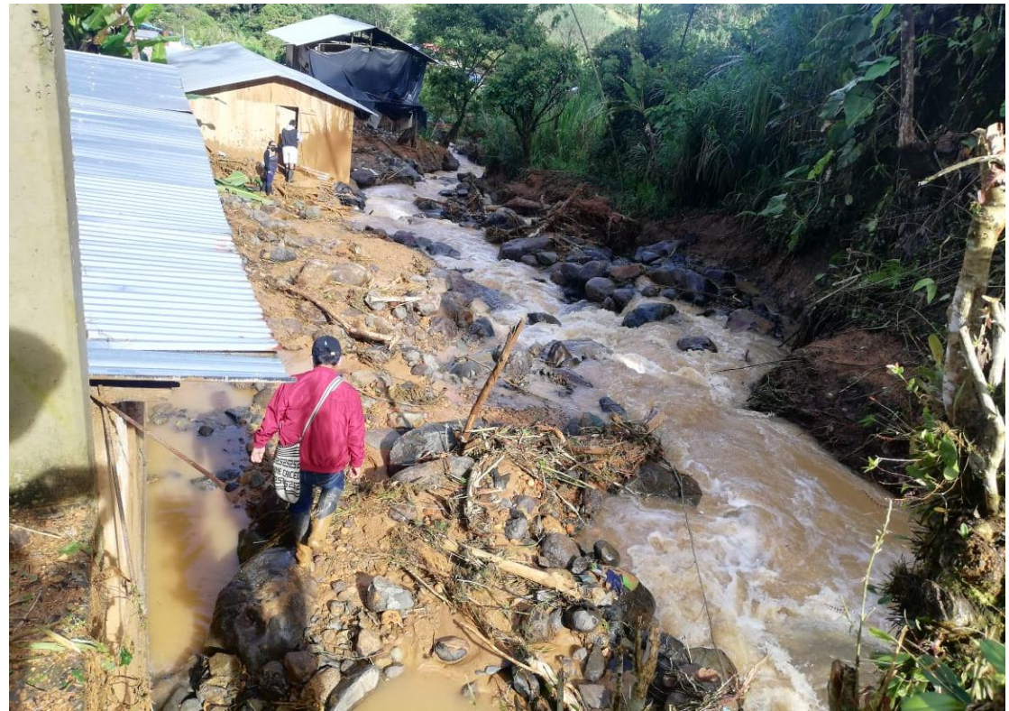
Ilustración 45 Desbordamiento de quebrada en sector Chambú. Fuente Oficina de Gestión del Riesgo 2020
