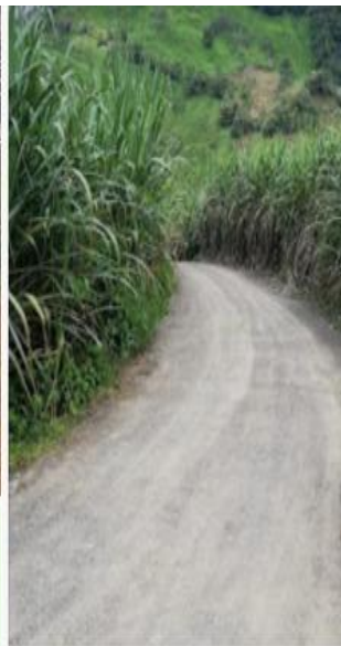
Recebo de vía San Pablo a Ricaurte 2.5 km
