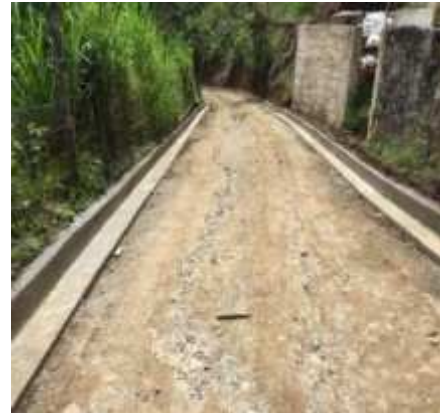
Ilustración 118. Registro fotográfico de la construcción de 164 metros de bordillos, cunetas y mantenimiento de vía corregimiento de Casabuy
