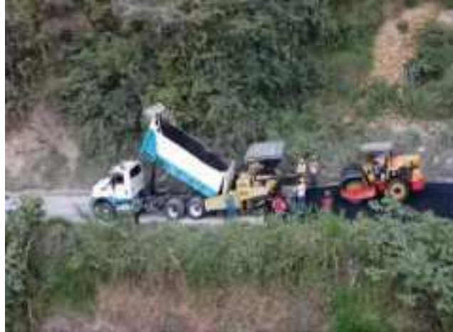
Ilustración 126. mejoramiento con concreto asfáltico de 450 ml de la vía de acceso al corregimiento de Casabuy segunda etapa
