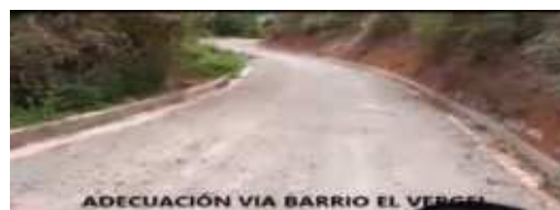
Ilustración 127. Adecuación Barrio Vergel
