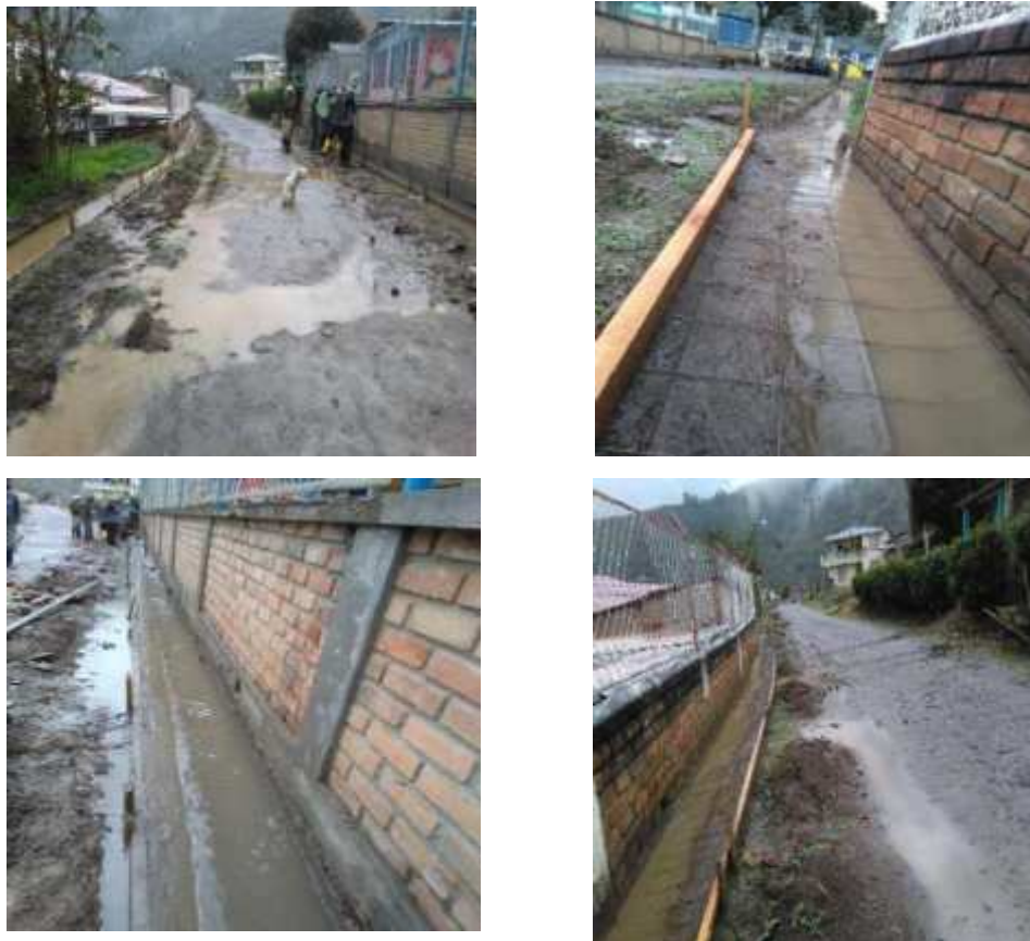
Ilustración 119. Registro fotográfico del mejoramiento de la vía secundaria 25 nr18 Chachagüí – la Cruz – Pasizara – Merlo – San Antonio – Villa Morena
