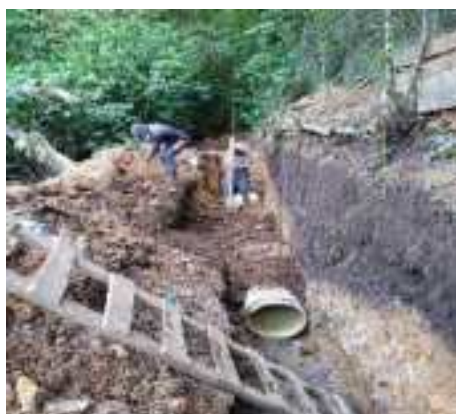
Ilustración 70. Registro fotográfico Construcción y ampliación del colector principal del sistema alcantarillado combinado sector de Guapiuy
