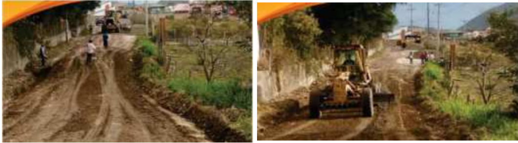
Ilustración 132. Mantenimiento y mejoramiento de la vía de Cimarrones
