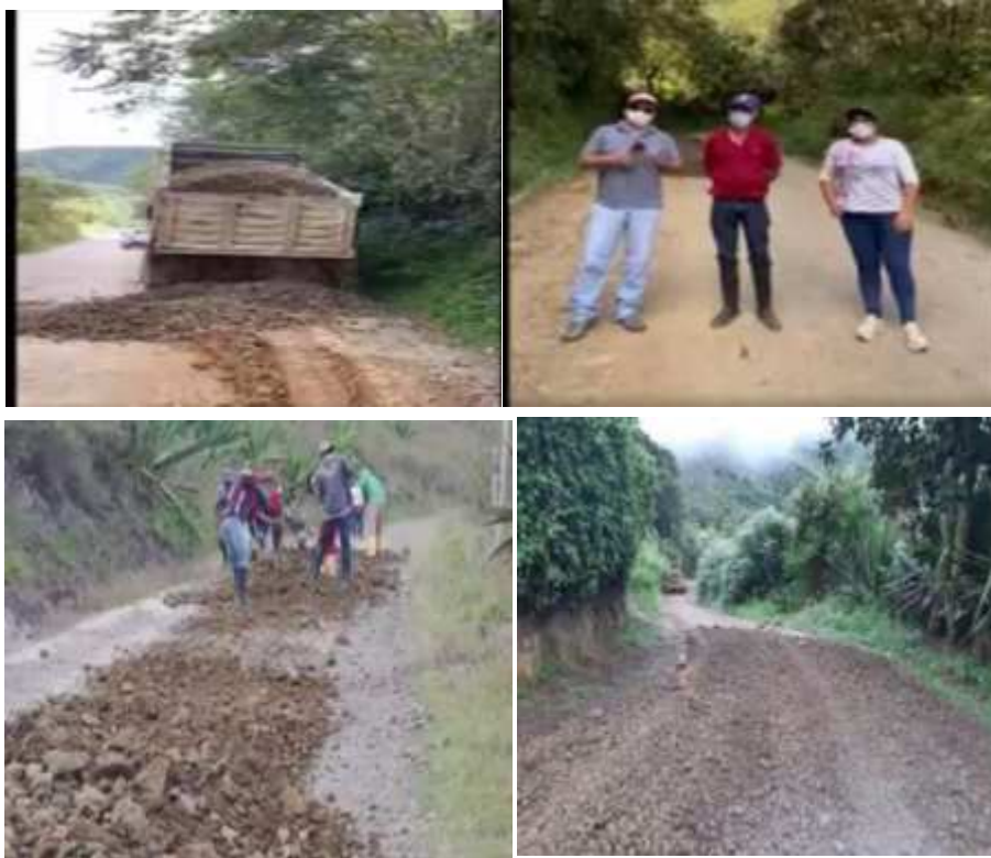
Ilustración 131. Mantenimiento de Vías Terciarias.
