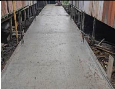
Vaciado y acabado de losa en concreto
