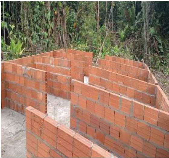
Levantamiento muros ladrillo
