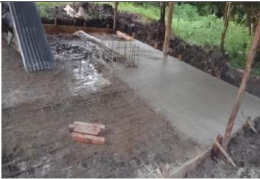
Proceso de fundición y armado de la placa para la estructura
