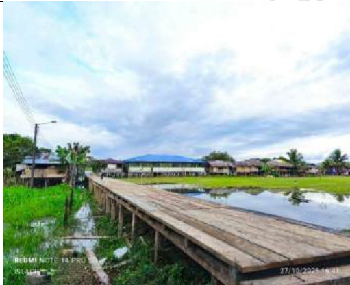
Instalación de piso en madera
