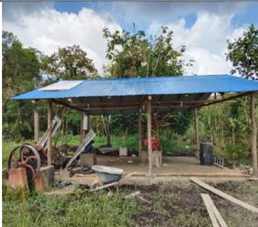
Vista general de la infraestructura finalizada y operativa
