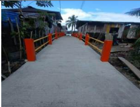
Puente en concreto terminado
