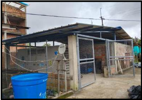
Resultado final de la caseta construida y en funcionamiento
