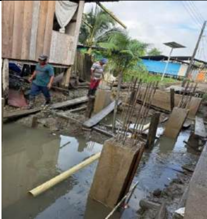
Cimentación y construcción de apoyos estructurales
