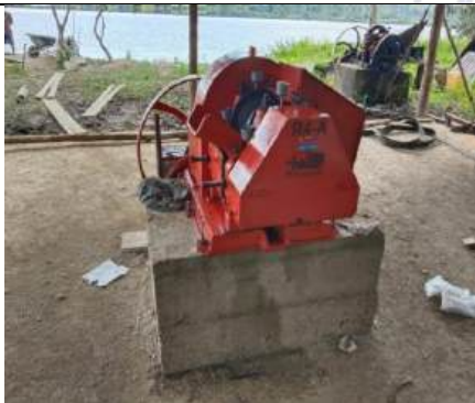
Ubicación e instalación del trapiche sobre la base en concreto
