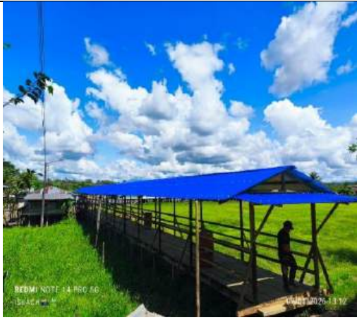
Vista Puente terminado
