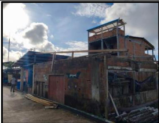
Estructura para cubierta
