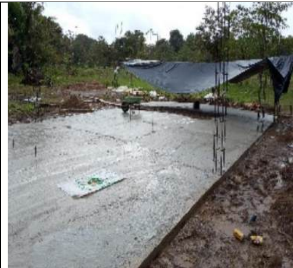
Fundición y placa concreto
