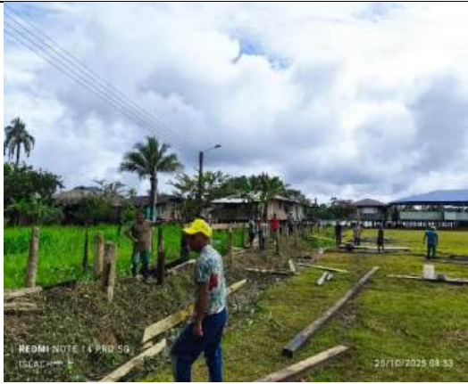
Limpieza y replanteo del terreno
