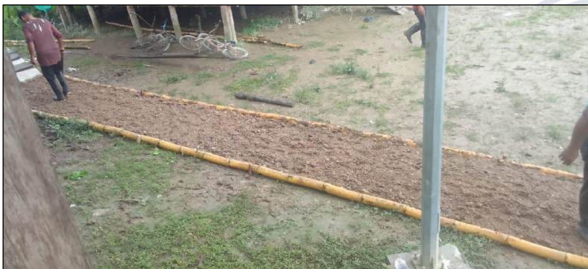
Suministro de balastro para el mejoramiento de la calle – Guarataco
