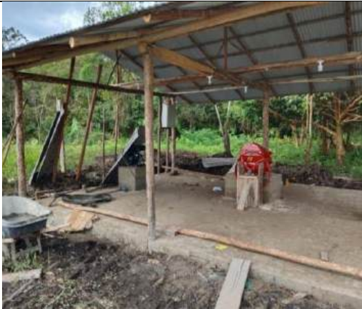
Construcción de la cubierta y adecuación del espacio productivo
