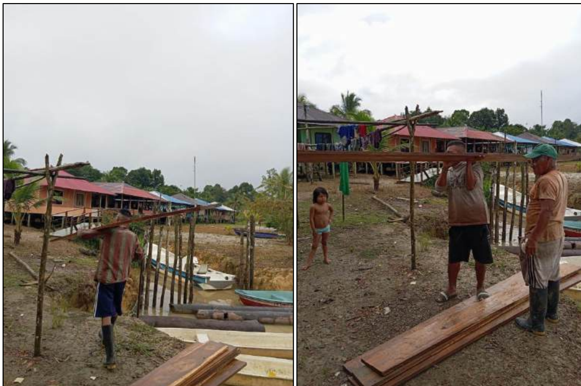
Suministro de madera para mejoramiento de vivienda – Puerto Guadualito
