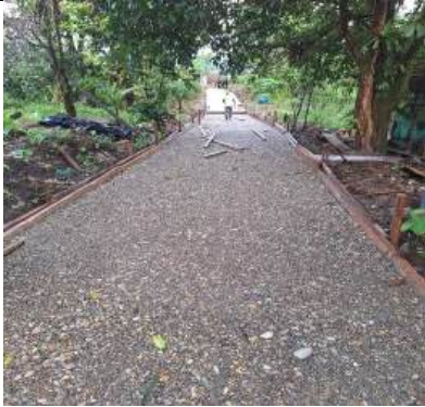
Preparación subbase vía
