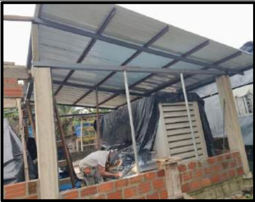
Instalación de cubierta y trabajos de soldadura durante la construcción
