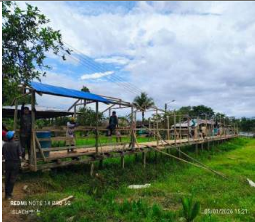
Estructura e instalación de barandas
