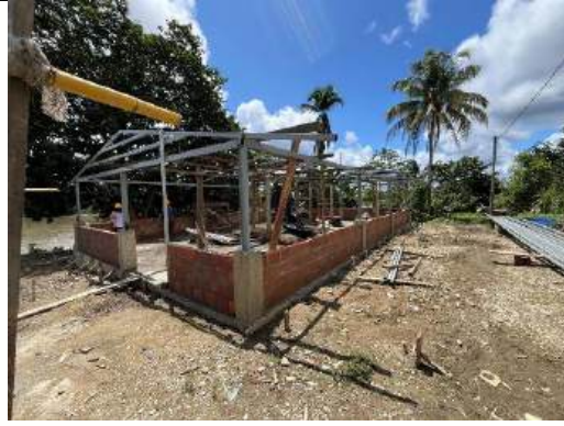
Estructura metálica y mampostería
