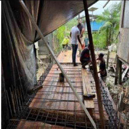
Armado de acero y formaleta para losa
