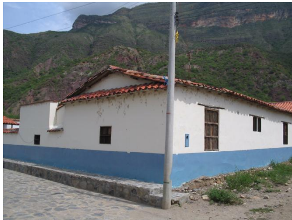
Instalaciones del centro de Salud.
