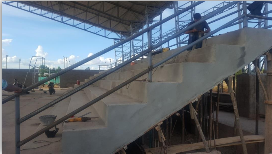
Figura 125: Proceso de Construcción del CIC en Puerto Carreño.
