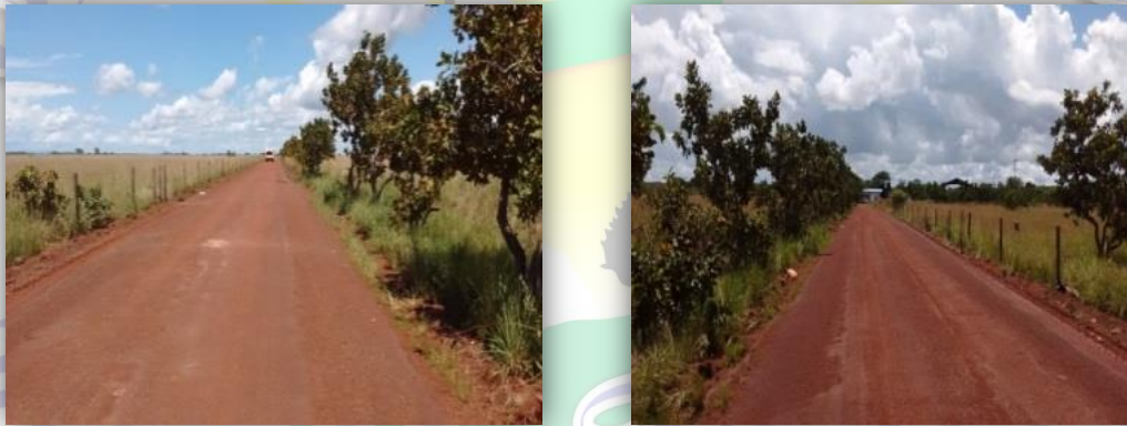
Figura 166: Arreglo de la vía de acceso al relleno sanitario.
