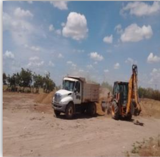
Figura 161: Proceso de confinación de residuos sólidos con buldócer en el área B de la celda.
