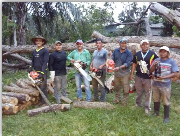
Figura 151: Equipo de la Administración municipal dedicado al despeje de vías.
