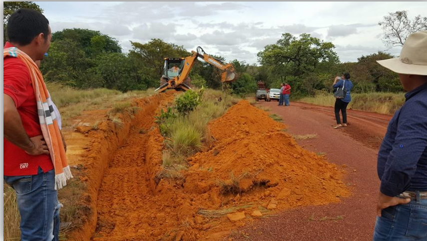
Figura 115: Mejoramiento del Terraplén de entrada a Casuarito.
