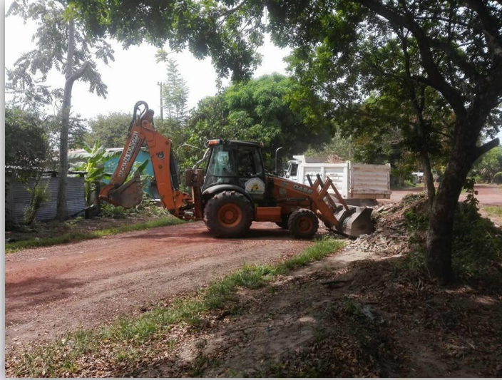
Figura 111: Mejoramiento de vías urbanas del Municipio.
