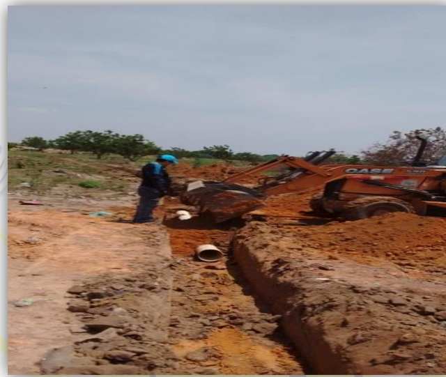
Figura 163: Soporte del Mantenimiento realizado a canales de Instalación
