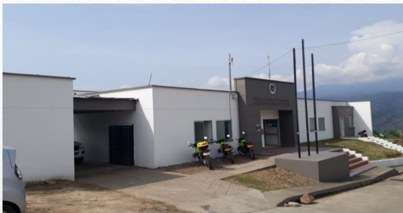
Pintura fachada exterior Estación de la Policía
