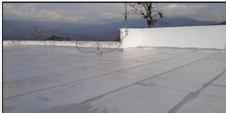
Impermeabilización bloque central Estación de Policía
