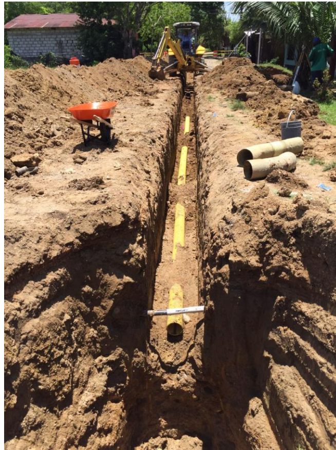
Alcantarillado Pto. Perales
