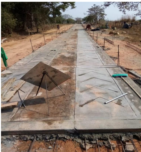
Placa Huella en construcción a la salida de la cabecera
