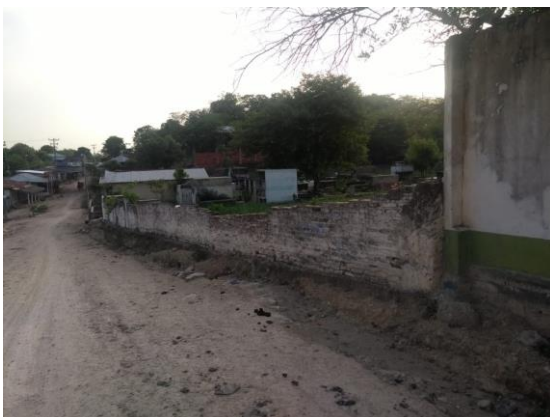
Muro de cerramiento externo
