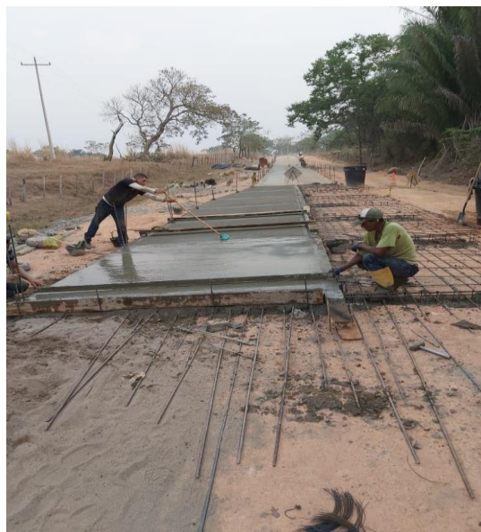
Placa Huella en construcción a la salida de la cabecera
