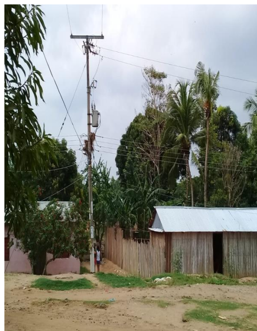
Redes eléctricas en espacio público de la cabecera municipal.
