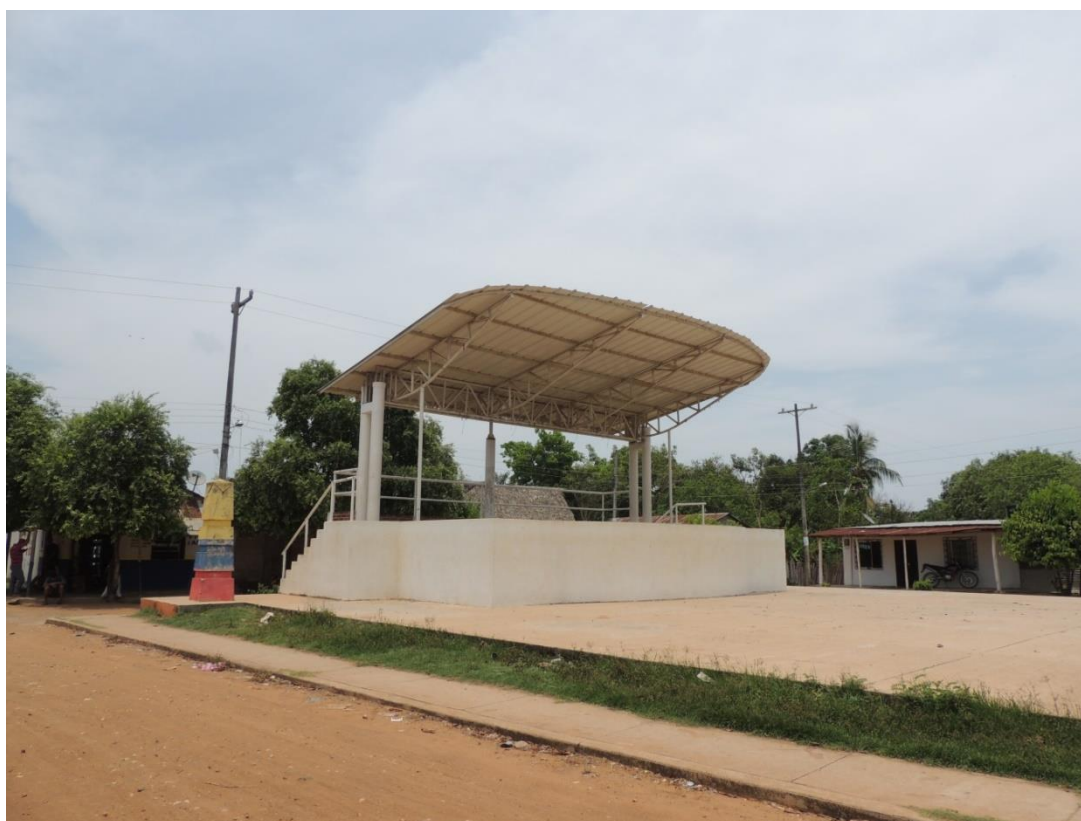
Tarima para espectáculos de las artes escénicas, ubicada en la cancha central del corregimiento de Chimí (única nivel municipal).
