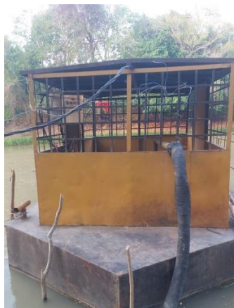
Bocatoma del Acueducto de Playitas
