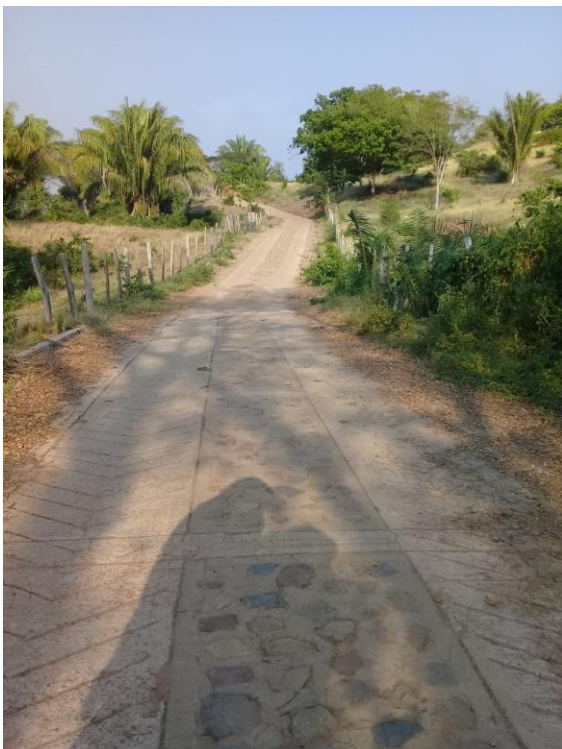
Placa Huella vía que conduce a Playitas
