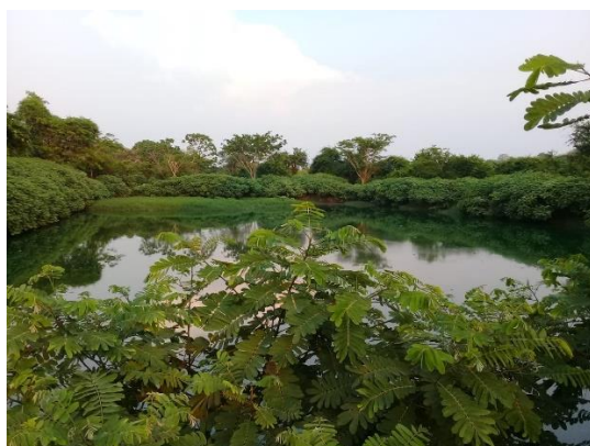
Laguna de oxidación de las aguas servidas
