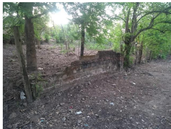
Muro de cerramiento interior
