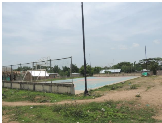
Cancha Múltiple. Corregimiento de Chimí Barrio Santa Inés
