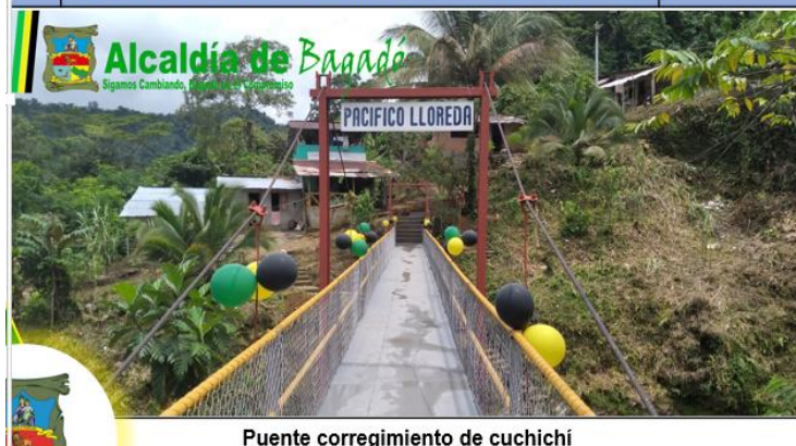
Puente correjimiento de cuchichi
