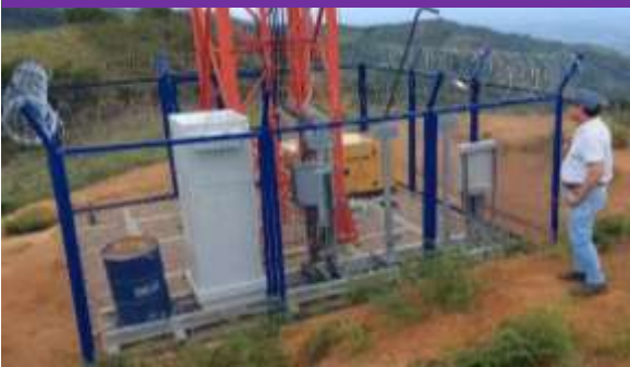
Instalación De Las Torres O Antenas De Comunicación, En La Vereda La Troja, Que Cubre Un Promedio De 5 Veredas .
