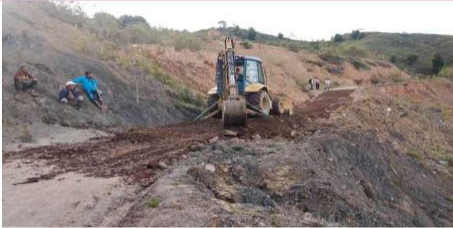
Rehabilitación de la vía veredas Las Perlas, Venadito y Laureles,
