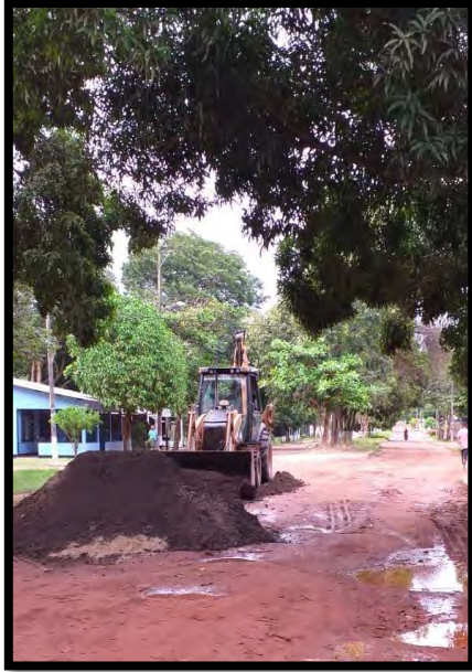
Tendida de material para recuperación de vías , en los barrios Las Escudillas , Villavenancio y Mateo con Minicargador , retro y Vibrocompactador
