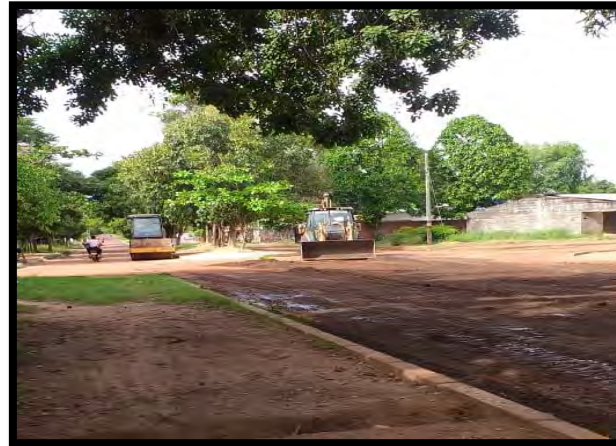
Tendida de material para recuperación de vías , en los barrios Las Escudillas , Villavenancio y Mateo con Minicargador , retro y Vibrocompactador
