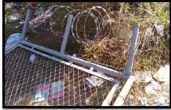
Daños ocasionados al cerramiento del relleno
