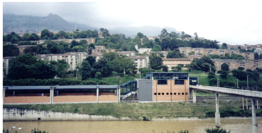
Vista de la estación y del barrio Tricentenario desde el costado oriental.
