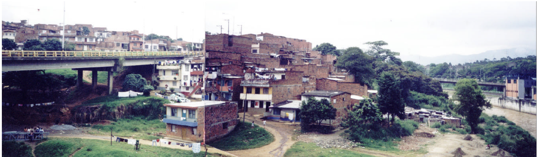
Costado oriental frente a estación del Metro Tricentenario
