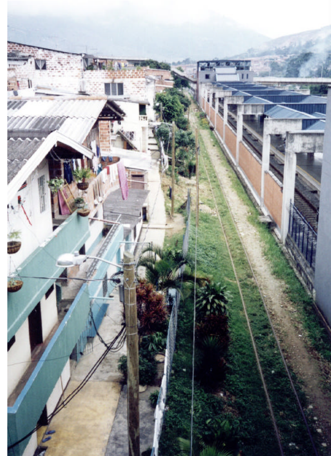
Viviendas a reubicar - aledañas a la estación Acevedo
