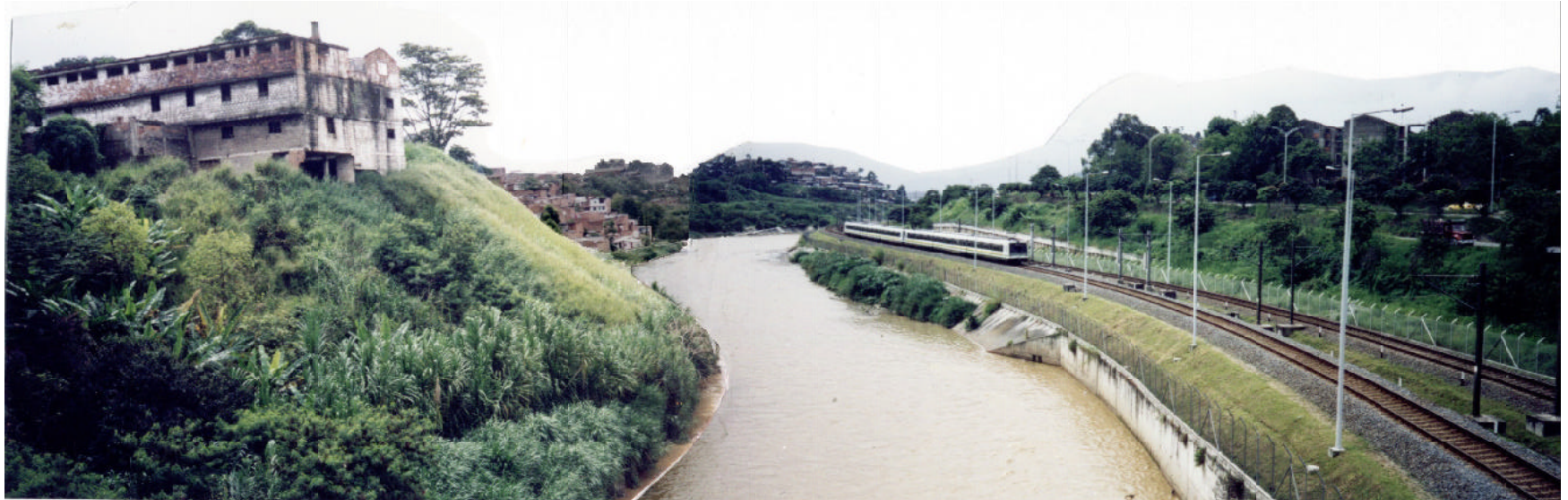
La topografía de los terrenos del Fuerte Palermo posibilitan la construcción de un tramo de túnel para el paso de la vía oriental y el acceso peatonal directo desde San Isidro hasta el río.
