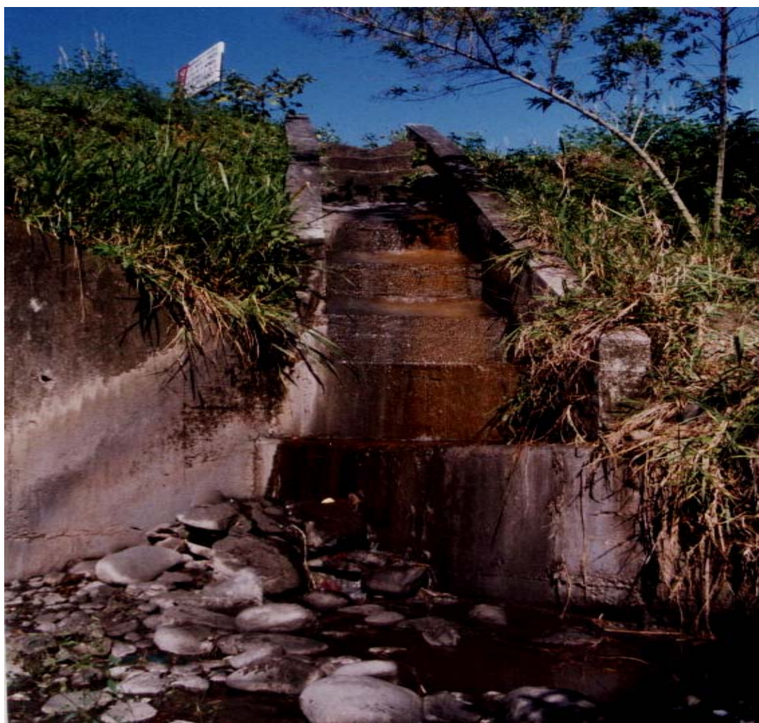
Fotografía No. 24. - Emisario final del Alcantarillado sobre el río Gualí.
