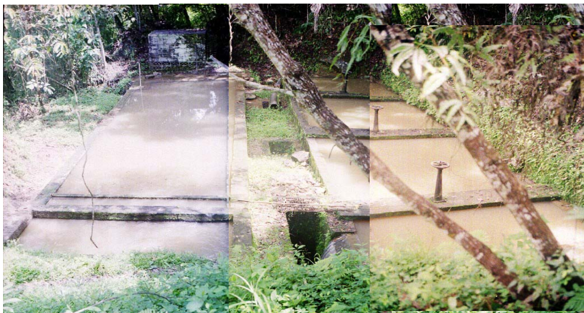
Fotografía No. 19. Panorámica de los desarenadores. A la izquierda se observa el desarenador No. 1 o viejo y a la derecha el nuevo.
