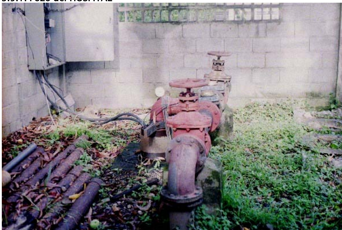
----- Fotografía No. 10 - Pozo del Hospital.
