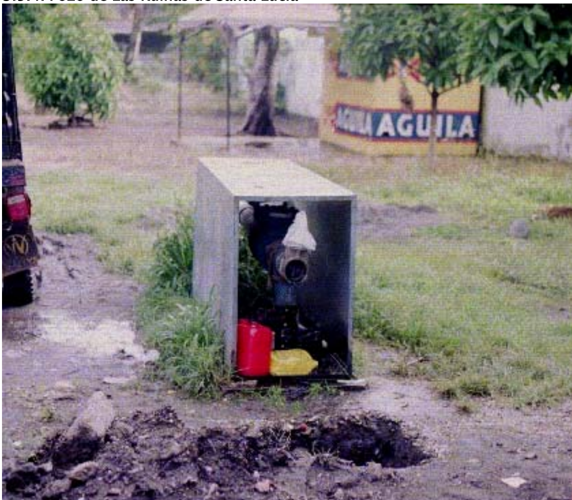
----- Fotografía No. 13 – Pozo de Santa Lucia .
