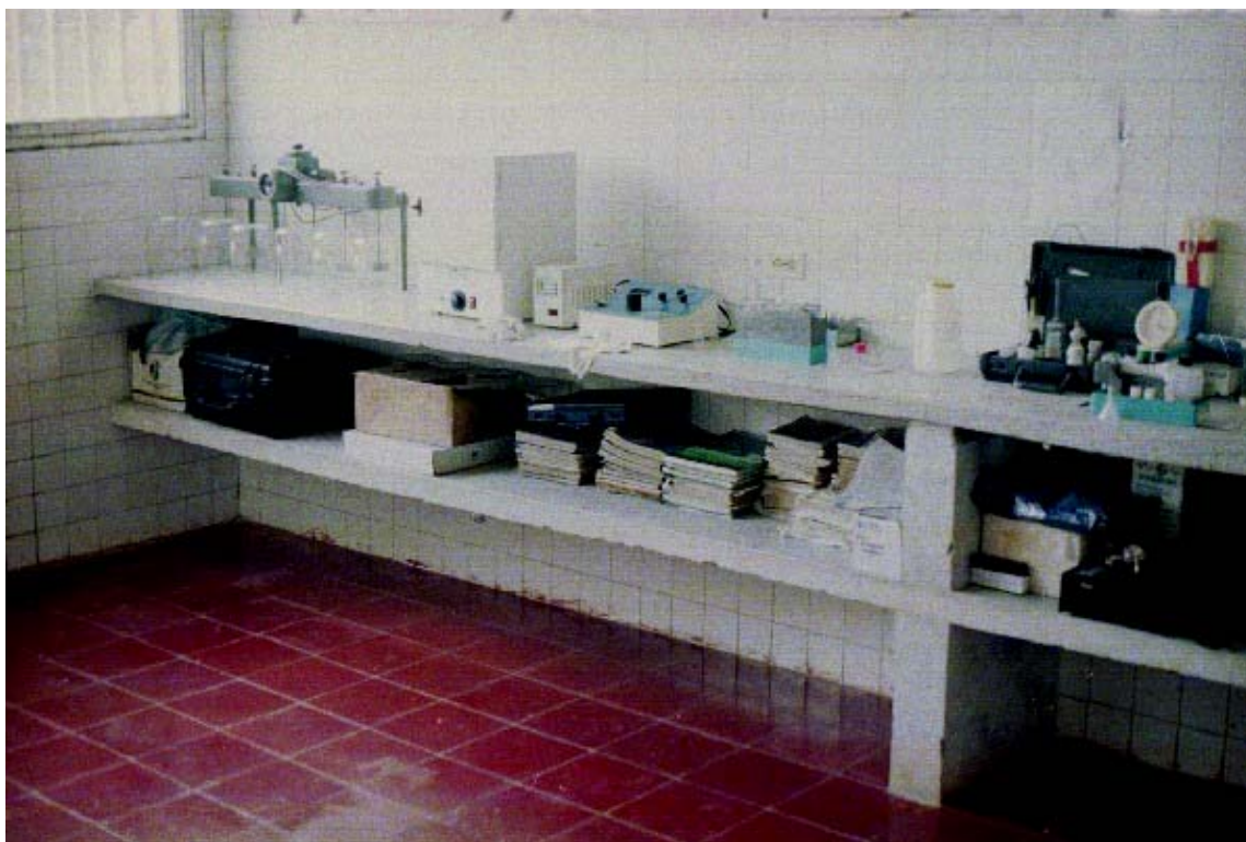
----- Fotografía No. 21. – Laboratorio de la Planta de Tratamiento.
