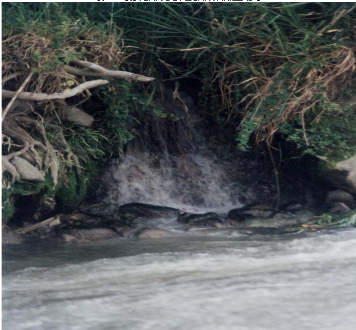
Fotografía No. 23. - Emisario del alcantarillado sobre el río Guaí.
