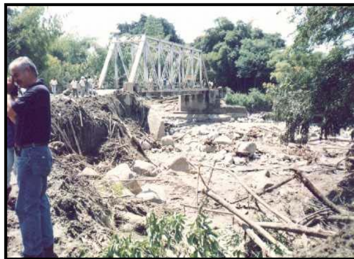
Puente sobre el río Desbaratado, afectado por la desbordamiento del río el 14 de enero de 1999, se observa la cantidad de material de arrastre que sobrepaso la altura del puente (foto, Comité Local de Emergencia, 1999).
