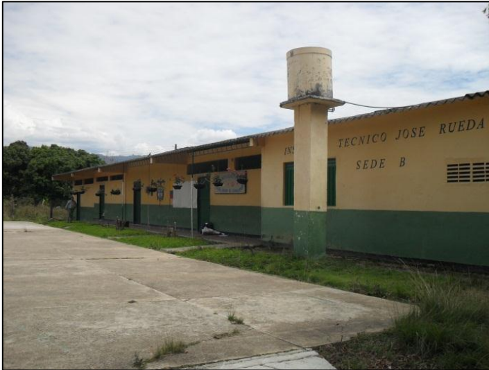
Instalaciones Sede Educativa Vereda Palo Gordo
