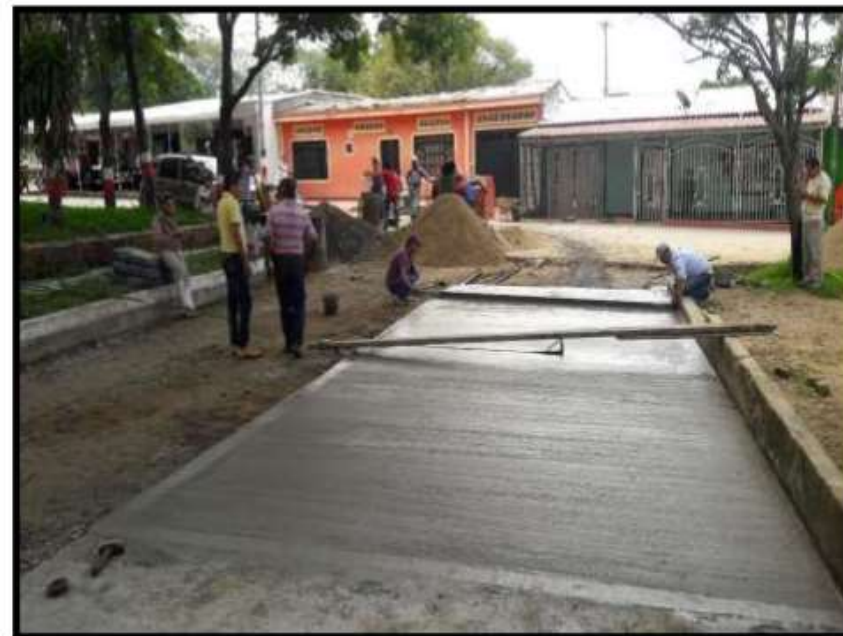
EJECUCION DE TRABAJOS
