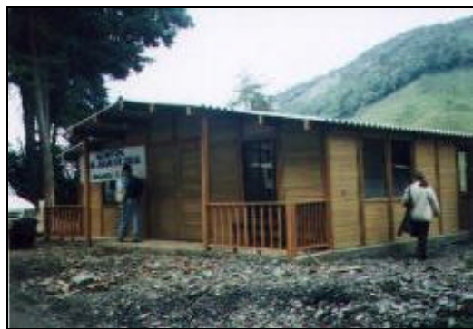
Centro de Salud construido provisionalmente en El Albergue
