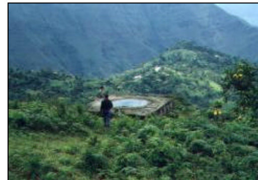
Tanque de distribución del acueducto veredal de Pinipay, el cual se localiza en la cima de la montaña y llega a las viviendas por gravedad sin realizarle tratamiento al agua.
