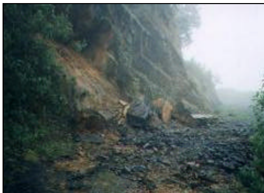
Tramo de la vía que conduce a la escuela de Chinga Siberia sobre la cual se producen frecuentes deslizamientos de material
