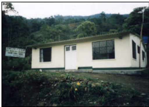
Puesto de salud Santa María de Camancha de la vereda Camancha. San Cayetano cuenta con infraestructura adecuada en salud, las principales deficiencias se presentan en dotación médico hospitalaria y en la falta de prestación del servicio médico con mayor frecuencia.
