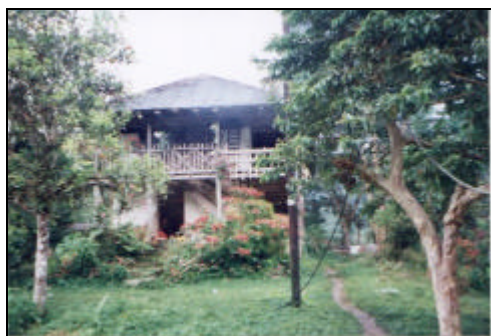
Casa Vieja – Patrimonio construido del Centro Poblado de La Montaña
