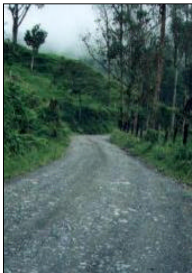
Vía de acceso principal al Municipio de San Cayetano – Tramo de la Troncal Carbonera
