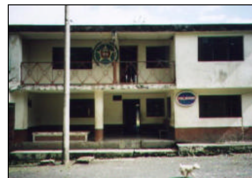
Edificación donde anteriormente funcionaba la Inspección de Policía de Camancha y donde aún se encuentra TELECOM
