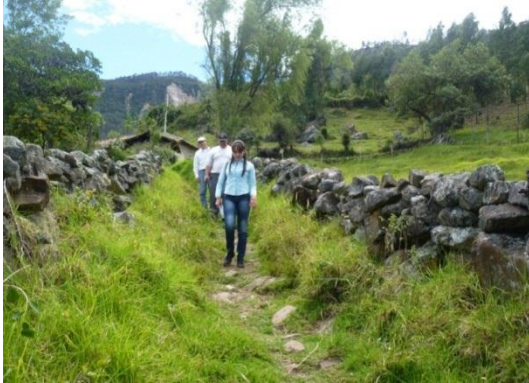
La IE la Chapa no cuenta con una vía de acceso.
