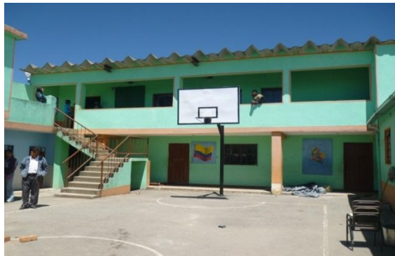
Fotografía 13. Campo deportivo Sede Santa Lucía.
