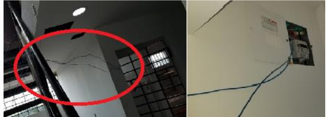
CAJA DE DISTRIBUCIÓN ELÉCTRICA QUE ALIMENTA TODO EL ESTABLECIMIENTO DE FÁCIL ACCESO A LAS INTERNAS
