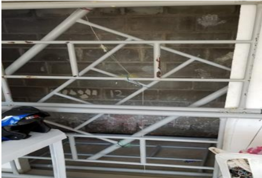
PARTES DE CAMAROTES USADOS COMO REJAS DE SEGURIDAD EN ZONAS VULNERABLES
