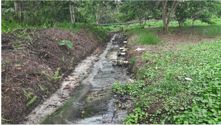
Ilustración 31 Descarga vertimiento campo de infiltración.
