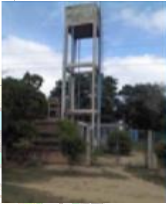
Tanque la Loma
