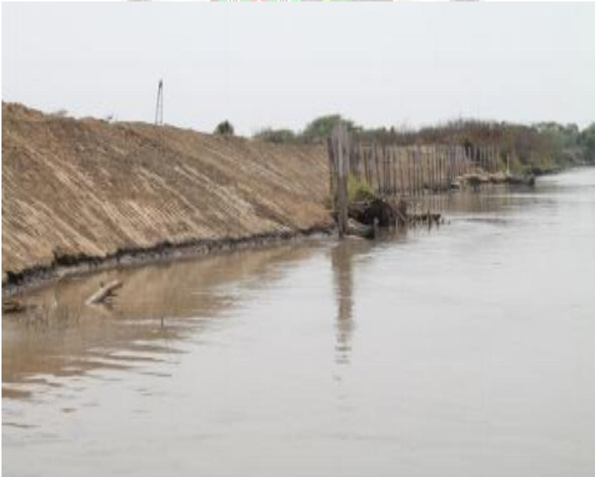
Imagen 4. Salamina. Obras ejecutadas sobre la margen del río Magdalena
