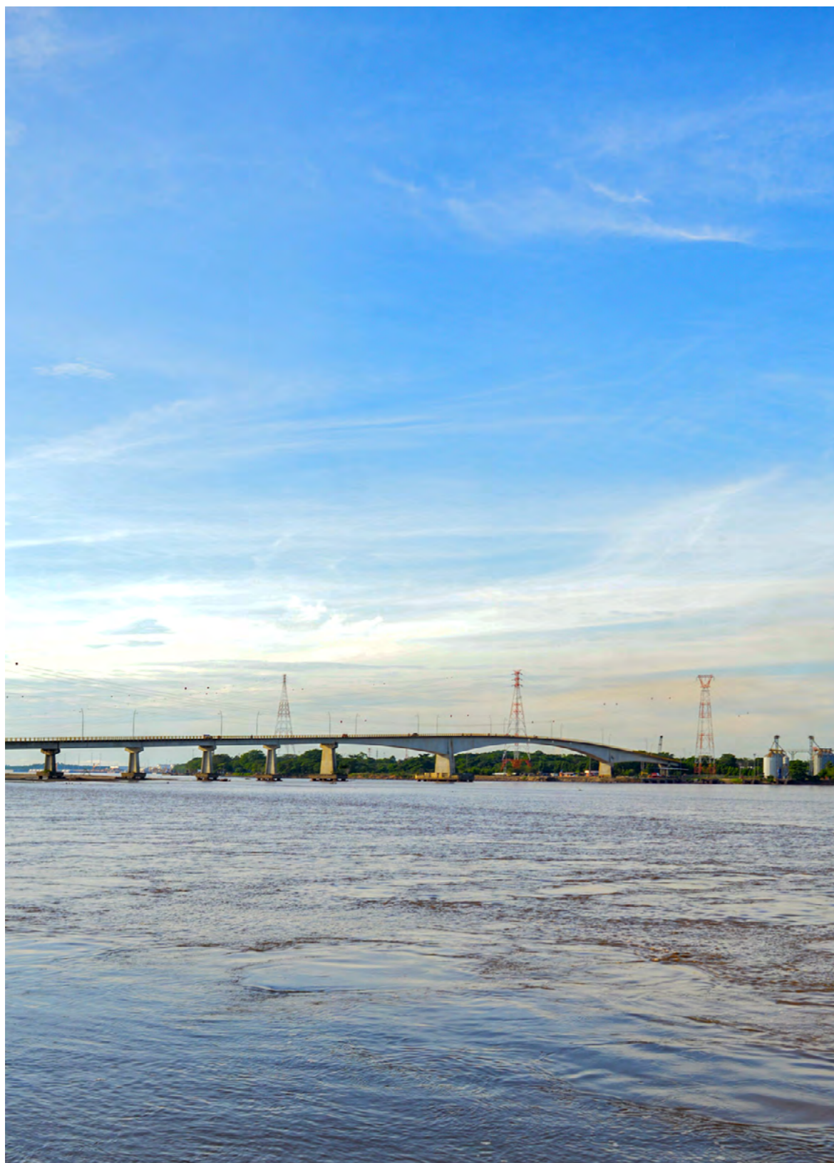
Foto: Puente Guillermo Gaviria Correa, comunica al municipio de Yondó con Barrancabermeja.
