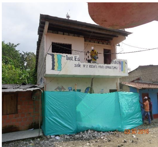
Antes de la intervención
