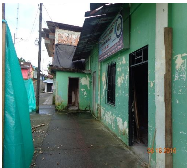
Antes de la intervención
