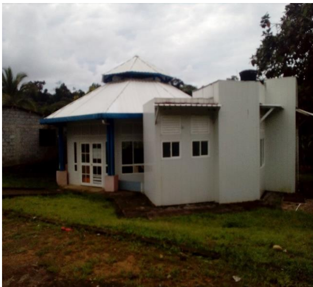
Antes de la intervención
