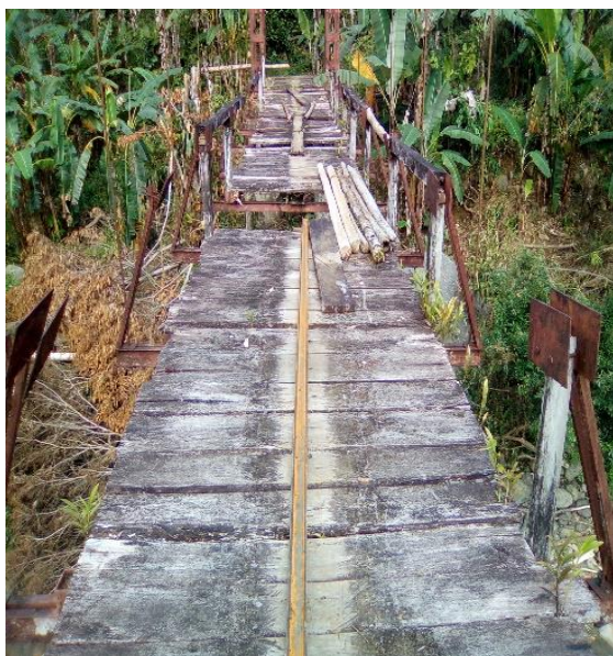
Antes de la intervención
