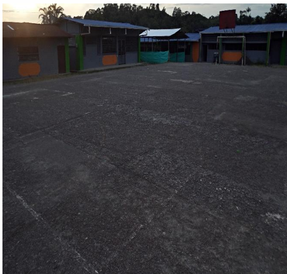
Antes de la intervención
