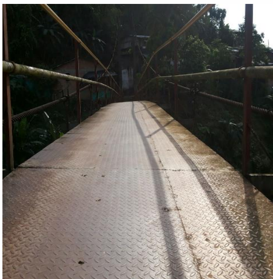
Antes de la intervención
