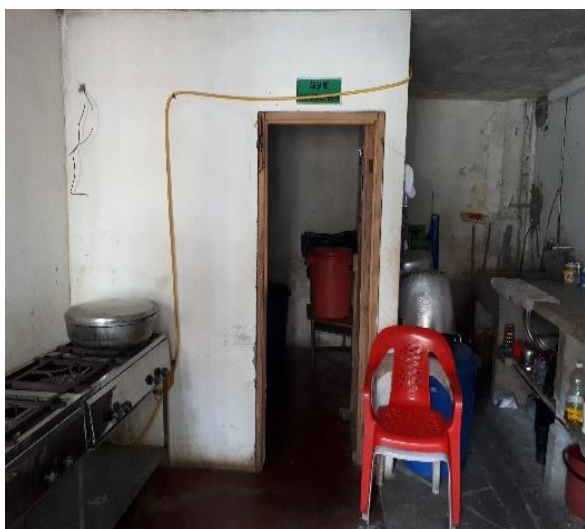
Antes de la intervención
