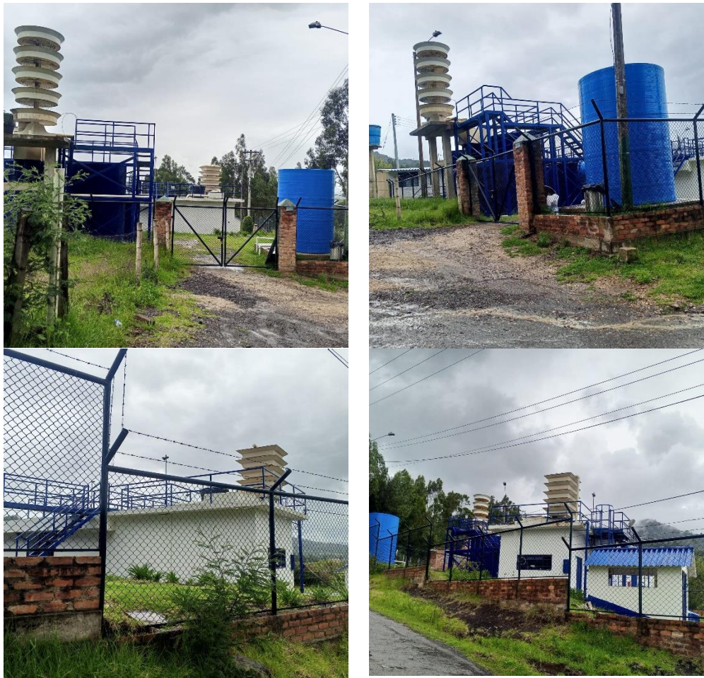
Figura 5. Planta de Tratamiento de Aguas Residuales – PTAR
