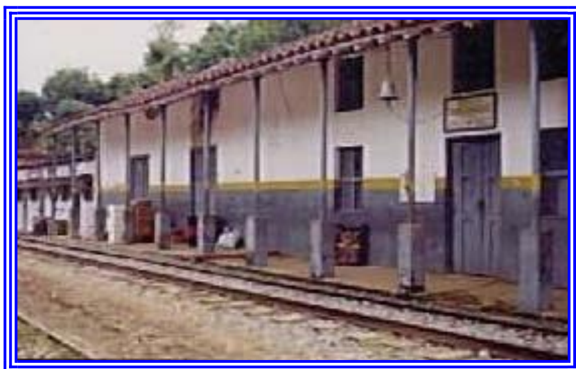
Foto 27. Vista frontal de la estación del Corregimiento de Virginias.
