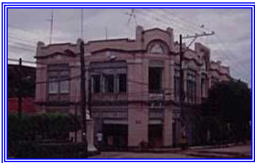
Foto 24. Edificio donde funciona Radio Venus.
