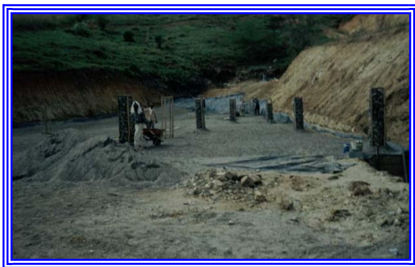
Foto 80. Construcción de filtros verticales para evacuación de gases, en la etapa constructiva.
