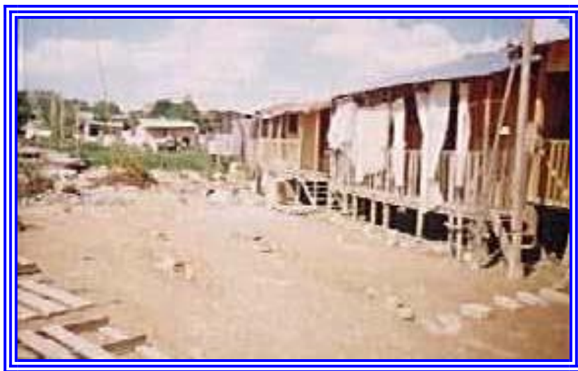
Foto 13. Condiciones físicas críticas
