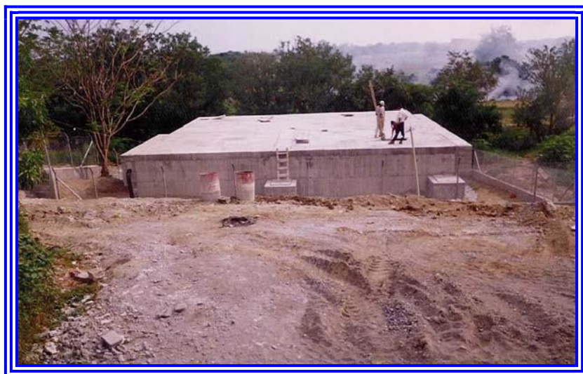
Foto 77. Planta de Tratamiento en el Sector El Pensil sin funcionar.
