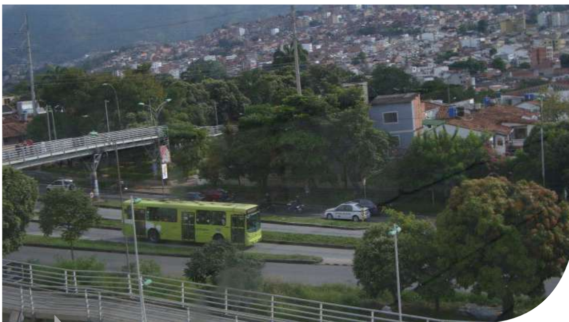
Sistema de Transporte Metrolínea – Autopista Floridablanca (CAEM-E3)
