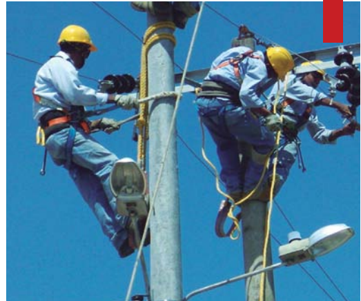
Instalación de nuevas redes
