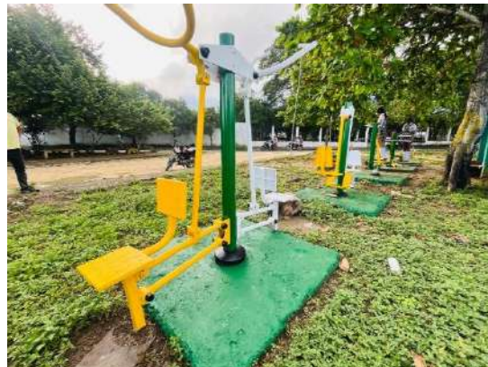
Ilustración 20 Reparación de parque plaza principal
