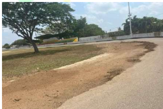
Ilustración 3 Reparación Pista de Patinaje
