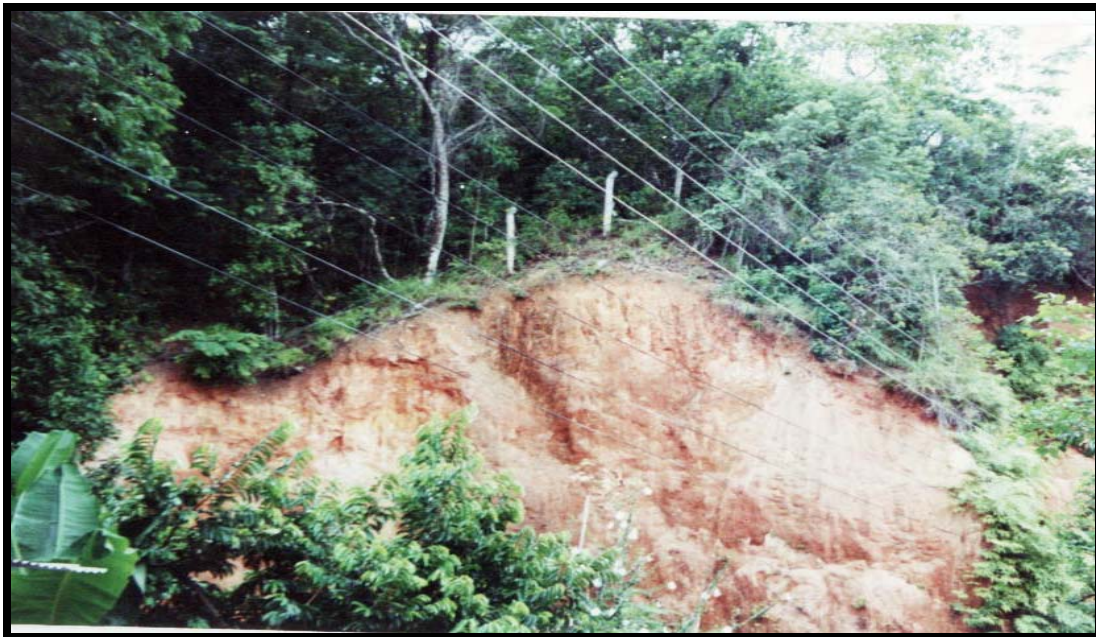
Figura 7. Procesos de desestabilización vía a Falan.
