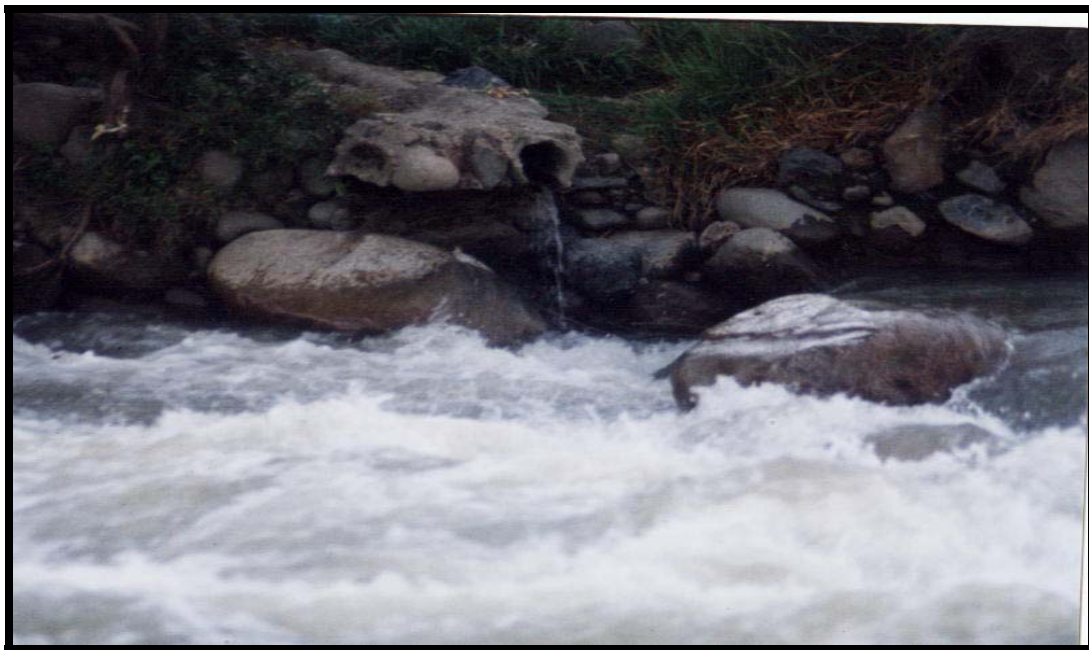
Figura 5. Descole de aguas negras del Alcantarillado sobre el Río Gualí
