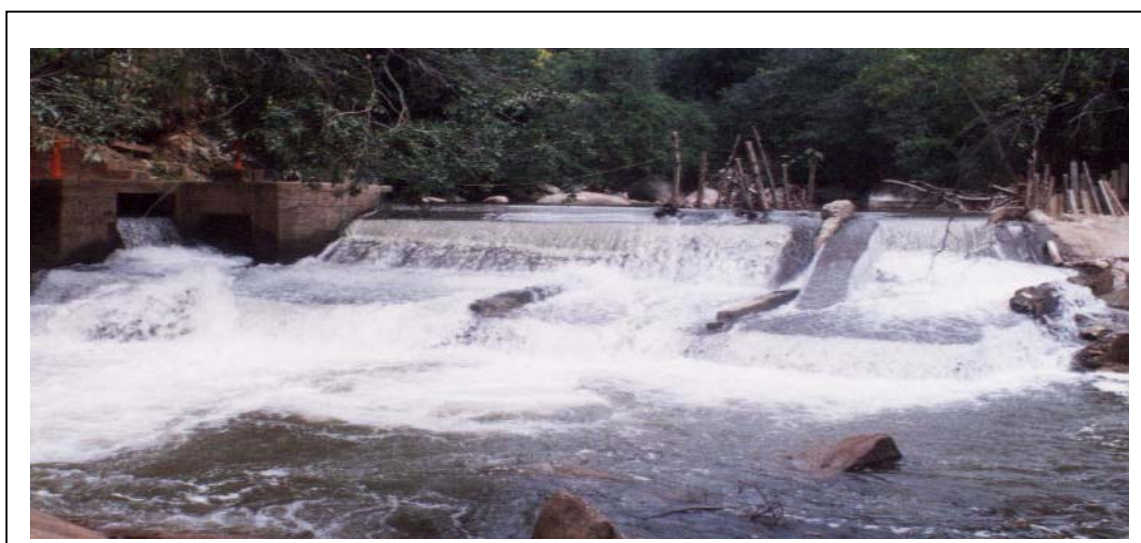
BOCATOMA ACUEDUCTO MUNICIPAL
